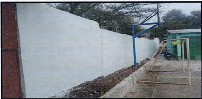
Foto 5: Reparación de banquetas de concreto
