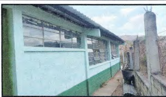
Foto 4: Reparación de losa de concreto en patio
