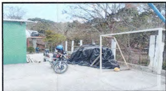
Foto 1: Reparación de muro perimetral de block
