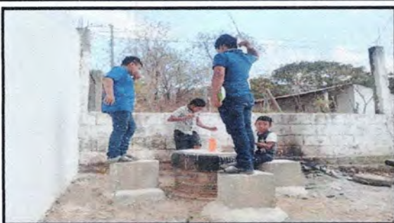
Foto 3: Repello de Muro Perimetral
