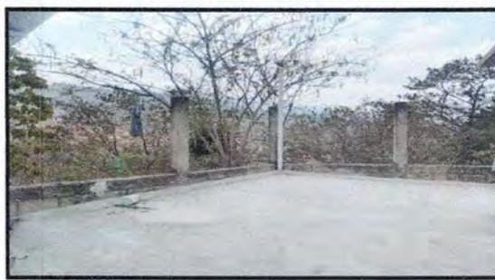
Foto 2: Reparación de muro perimetral
