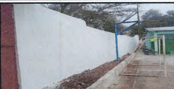
Foto 5: Reparación de banquetas
