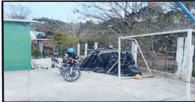
Foto 4: Reparación de losa de concreto en patio
