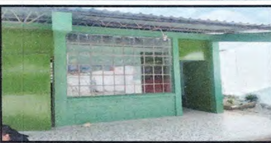
Foto 6: Sustitución de Canales de Pvc
