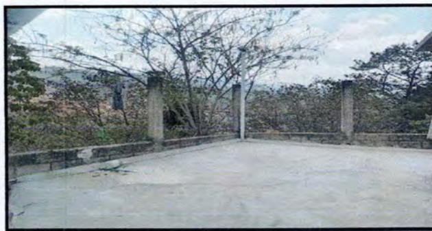
Foto 2: Reparación de muro perimetral de block
