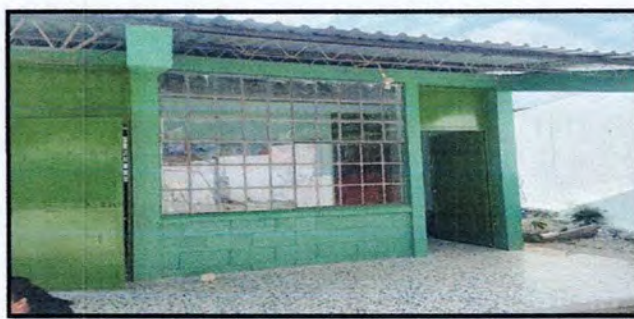
Foto 6: Sustitución de canal de pvc
