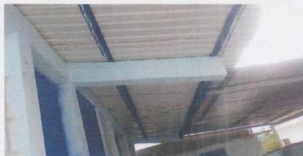
Foto 2: Reparación de Techo de aulas, cambio de cubierta, rehabilitación de Joist, cambio de lamina Troquelada Aluzinc Calibre 26 Legítimo
