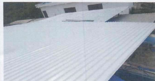
Foto 3: Reparación de Techo de aulas, cambio de cubierta, rehabilitación de Joist, cambio de lamina Troquelada Aluzinc Calibre 26 Legítimo
