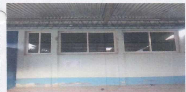
Foto 5: Sustitución de Balcones por Ventanas PVC
