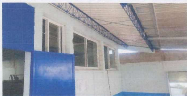
Foto 1: Reparación de Techo de aulas, cambio de cubierta, rehabilitación de Joist, cambio de lamina Troquelada Aluzinc Calibre 26 Legítimo
