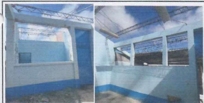
Foto 5: Sustitución de Balcones por Ventanas PVC
