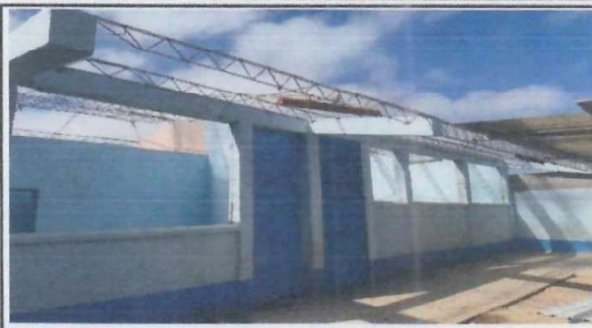
Foto 2: Reparación de Techo de aulas, cambio de cubierta, rehabilitación de Joist, cambio de lamina Troquelada Aluzinc Calibre 26 Legítimo
