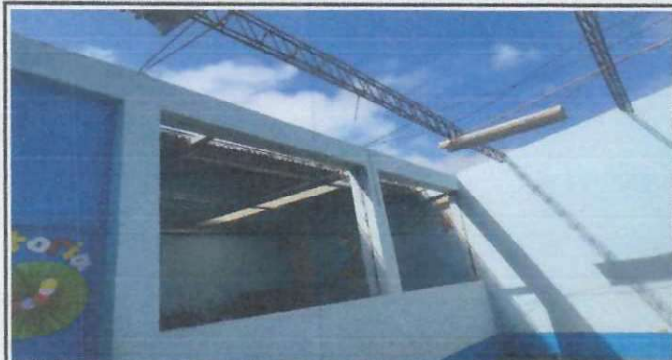
Foto 1: Reparación de Techo de aulas, cambio de cubierta, rehabilitación de Joist, cambio de lamina Troquelada Aluzinc Calibre 26 Legítimo
