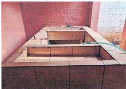
Foto 11: Reparación de tanque de agua
