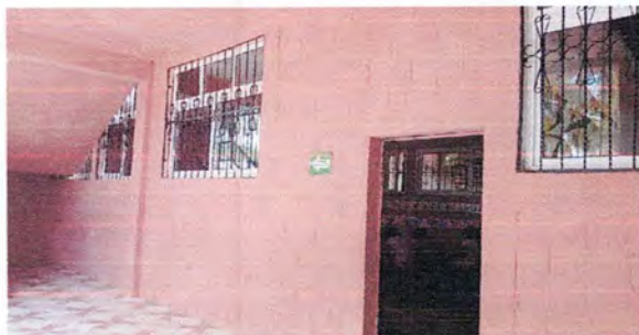
Foto 1: Instalación de ventana aula 1
