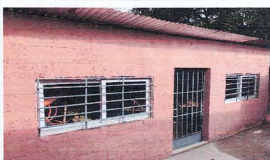
Foto 10: Instalación de ventanas en la bodega
