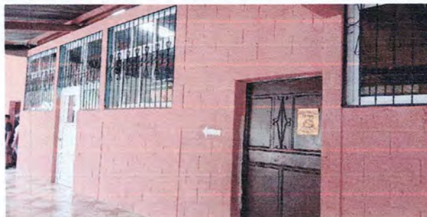
Foto 2: Instalación de ventanas en aula 3
