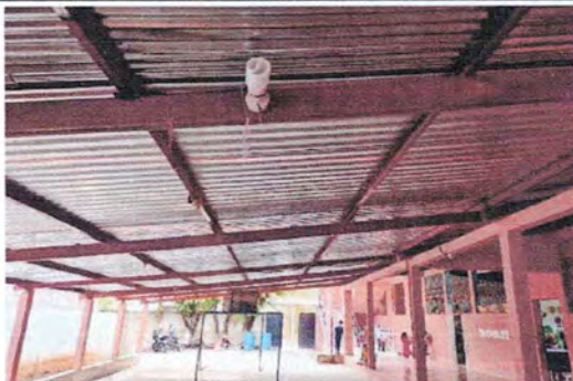
Foto 9: Sustitución de lámina en mini cancha
