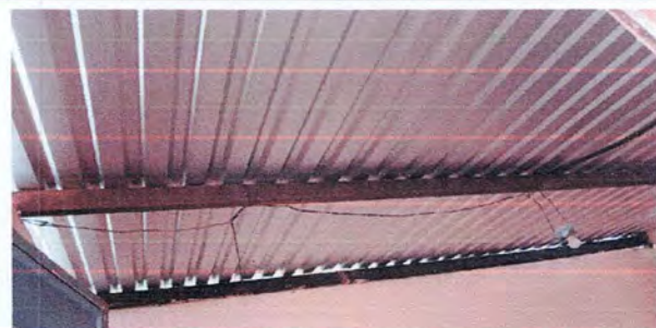
Foto 6: Instalación de lámina en cocina
