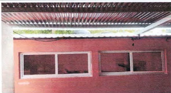
Foto 5: Instalación de ventana en cocina
