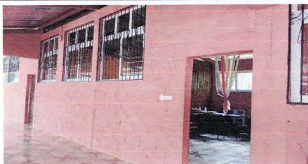
Foto 3: Instalación de ventana en aula 4
