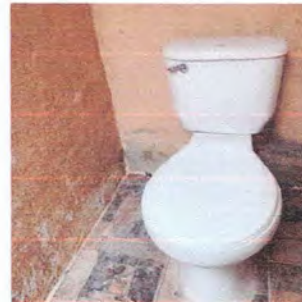
Foto 12: Instalación de baños
