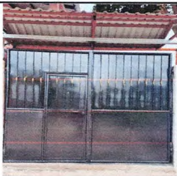
Foto 13: Reparación de portón y sombra de protección
