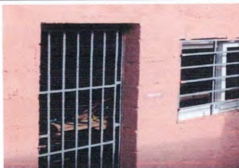
Foto 10: Instalación de ventanas en la bodega
