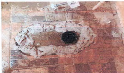
Foto 12: Instalación de baños
