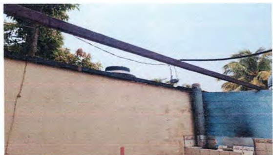
Foto 6: Instalación de lámina en cocina
