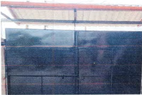
Foto 13: Reparación de portón y sombra de protección
