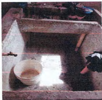
Foto 11: Reparación de tanque de agua
