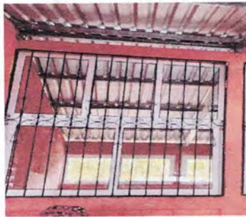
Foto 3: Instalación de ventana en aula 4
