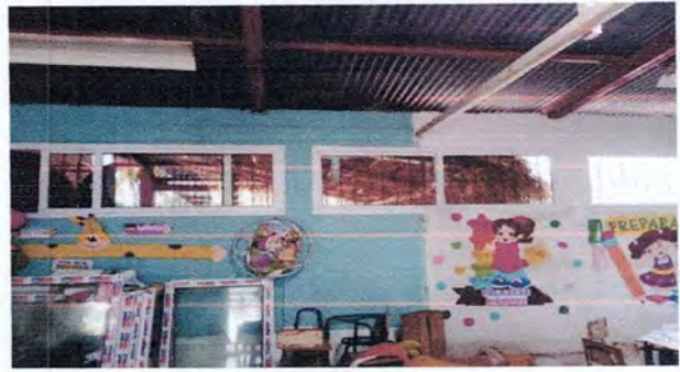
Foto 2: Instalación de ventanas en aula 3
