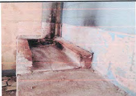
Foto 7: Sustrucción de plancha de leña
