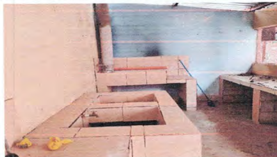
Foto 8: Reparación de tanque de agua en la cocina
