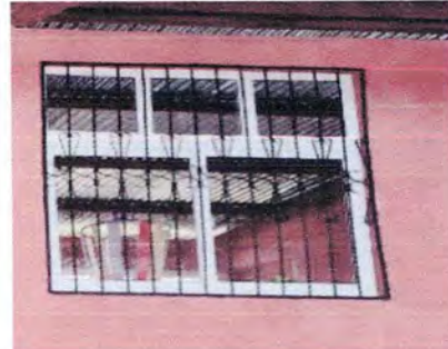
Foto 4: Instalación de ventana en aula 5
