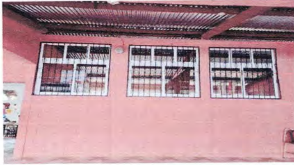
Foto 1: Instalación de ventana aula 1
