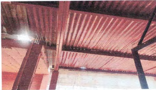
Foto 9: Sustrucción de lámina en mini cancha
