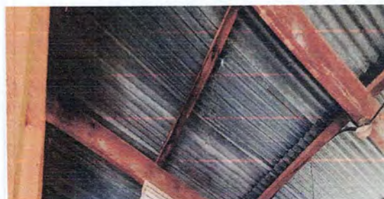
Foto 6: Sustitución de lámina en cocina
