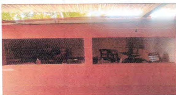
Foto 5: Instalación de ventanas en cocina
