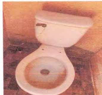
Foto 12: Instalación de baños
