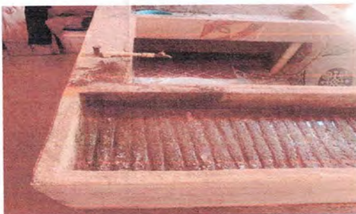
Foto 11: Reparación de tanque de agua
