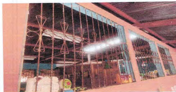
Foto 2: Instación de ventanas en aula 3
