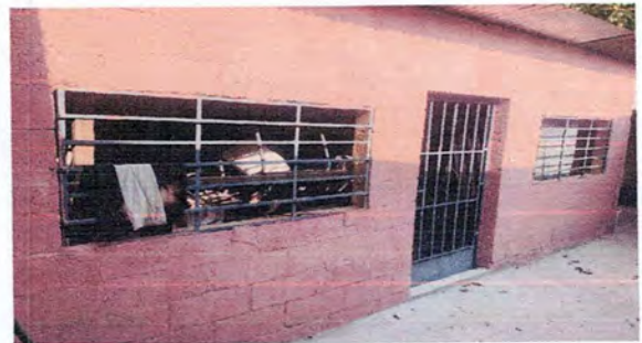
Foto 10: Instalación de ventanas en bodega
