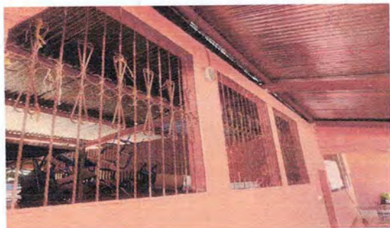
Foto 3: Instalación de ventanas en aula 4
