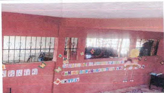
Foto 1: Instalación de ventanas en aula 1
