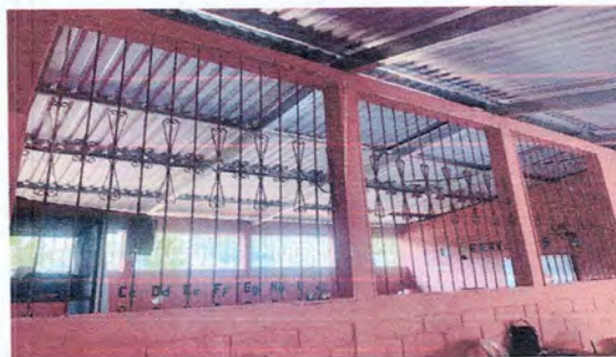
Foto 4: Instación de Ventanas en aula 5
