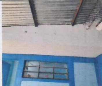
Foto 6: Impermibilización de Losa
