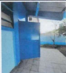
Foto 5: Mantenimiento de puertas.
