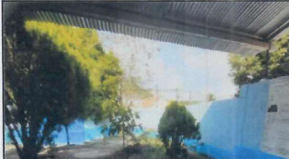
Foto 2: Cambio de malla por tabique de block a a muro perimetral y pintura.
