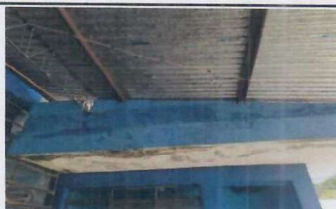
Foto 6: IMPERMEABILIZACIÓN DE LOSA
