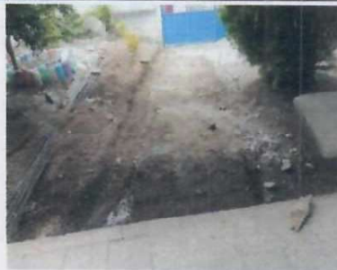
Foto 4: CAMINAMIENTO DE ENTRADA
