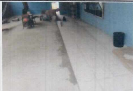
Foto 5: SUSTITUCIÓN DE PISO DE CONCRETO POR PISO CEMICO
