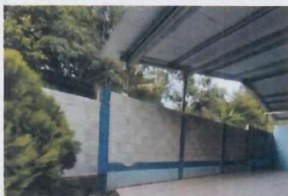
Foto 3: SUSTITUCIÓN DE MALLA POR TABIQUE DE BLOCK
