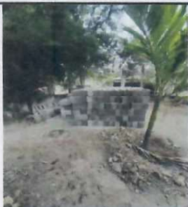
Foto 1: MATERIAL PARA MURO PERIMETRAL.
