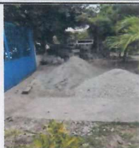
Foto 2: MATERIALES PARA CAMINAMIENTO DE ENTRADA
