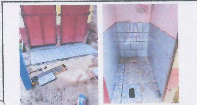
Foto 7: FUNDICION DE TORTA DE CEMENTO EN AREA DE REUBICACION DE PILA, INSTALACION DE PISO Y AZULEJO EN AREA DE BAÑOS .
