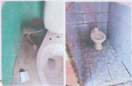
Foto 13: SUSTITUCION DE INODOROS.
