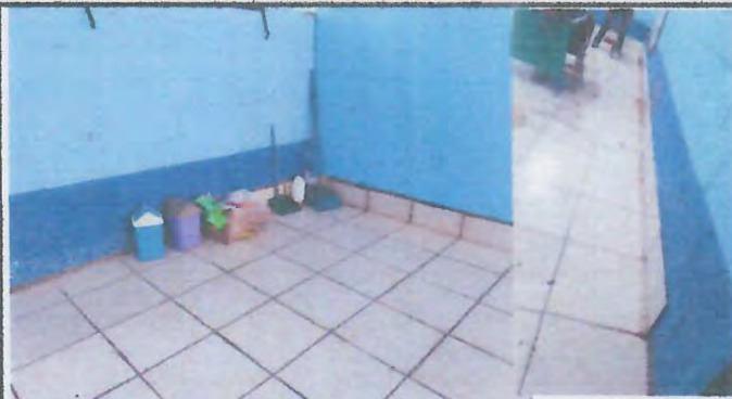
Foto 14: INTALACION DE ZOCALO EN AULA.
