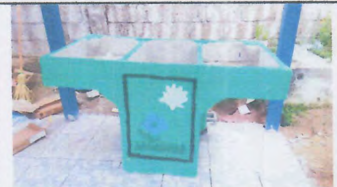
Foto 10: REUBICACION E INSTALACION DE PILA NUEVA.
