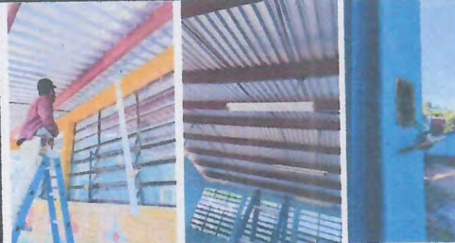
Foto 6: SUSTITUCION DE LAMPARAS.
