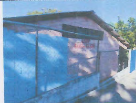
Foto 4: APLICACIÓN PINTURA EN MUROS EXTERIORES.
