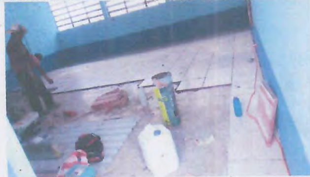
Foto 2: INSTALACION DE PISO CERAMICO.
