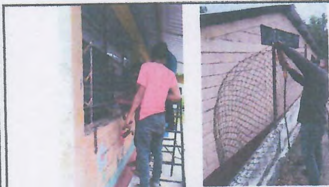
Foto 3: SUSTITUCIÓN DE VIDRIOS Y DE MALLA Y TUBO HG PERIMETRAL.
