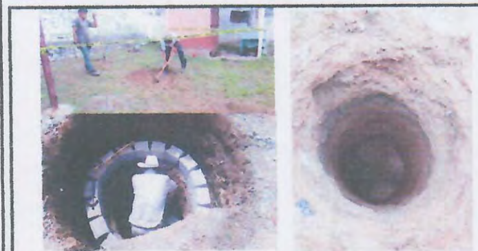
Foto 9: FABRICACION DE BROCAL Y APERTURA DE POZO.
