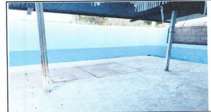
Foto 6: Mantenimiento a fosa séptica.
