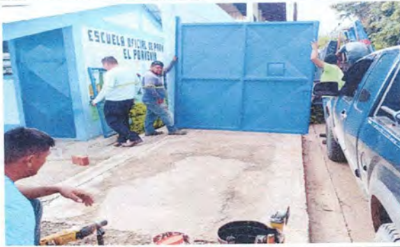
Foto 6: sustitución de porton de metal.
