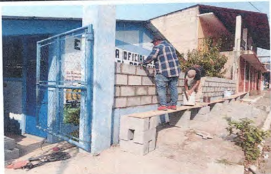
Foto1: Reparación de Muro perimetral con tabique para parte superior.
