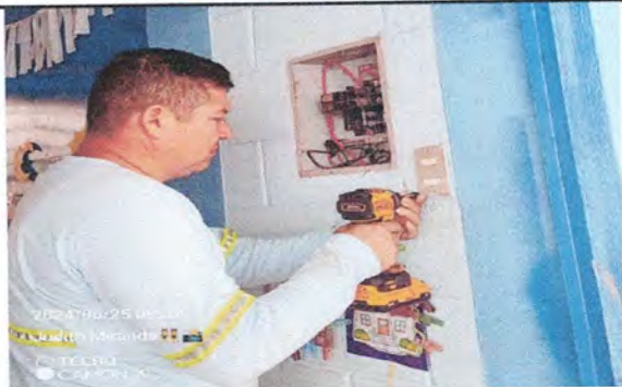
Foto 5: Reparación de Sistema Eléctrico
