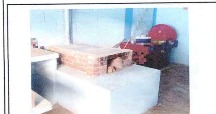
Foto 5: Reparación de cocina.
