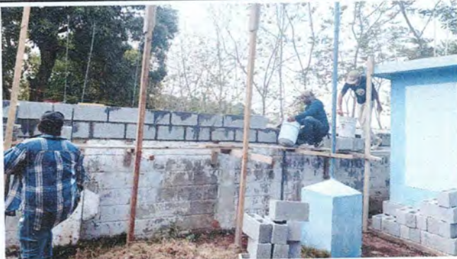
Foto 2: Reparación de muro perimetral
