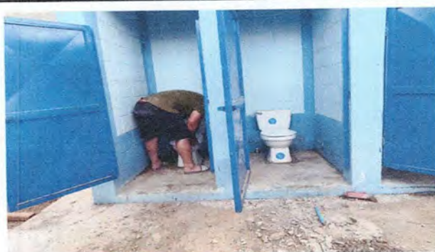
Foto 4: Reparación de Servicios Sanitarios
