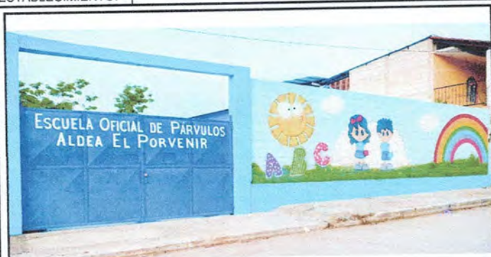
Foto 1: Reparación de muro perimetral frontal.
