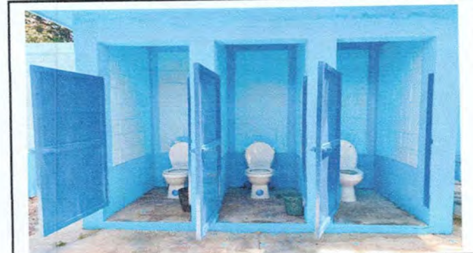
Foto 4: Reparación de servicios Sanitarios.
