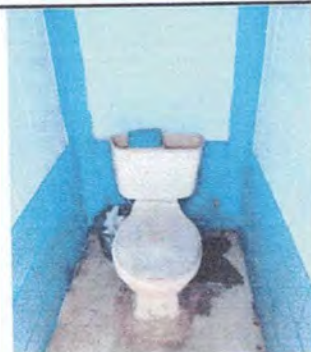
Foto 4: Reparación de Servicios Sanitarios
