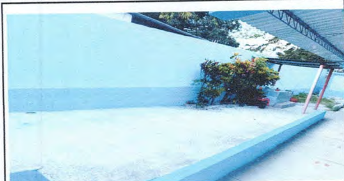
Foto 2: Reparación de muro perimetral con tabique en la parte superior.
