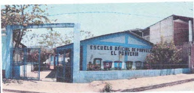
Foto 1: Reparación de Muro Perimetral con Tabique para parte superior.
