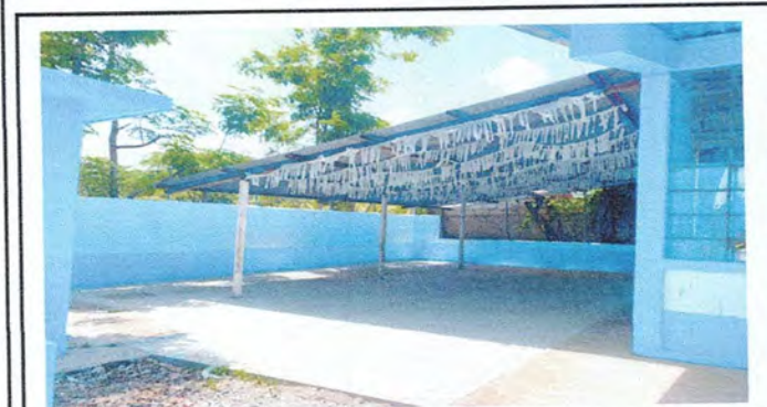
Foto 3: Reparación de piso de patio para actividades cívicas.
