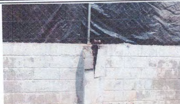
Foto 2: Reparación de Muro Perimetral.
