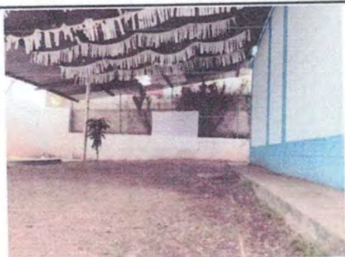
Foto 3: Reparación de Piso de Patio para actividades cívicas.
