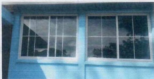
Foto 3.2 sustitución de ventanas de metal por ventanas de pvc
