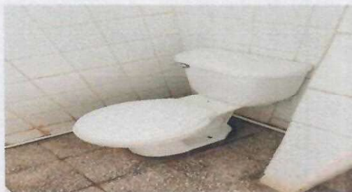
Foto 2.2 Sustitucion de inodoro
