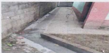
Foto 3.4 reparación de cuneta de concreto
