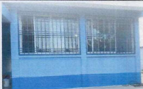
Foto 3.3 pintura de exteriores e interiores
