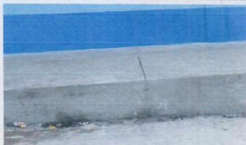
Foto 3.5 reparación de banqueta de concreto
