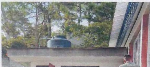
Foto 2.5 impermeabilización de loza
