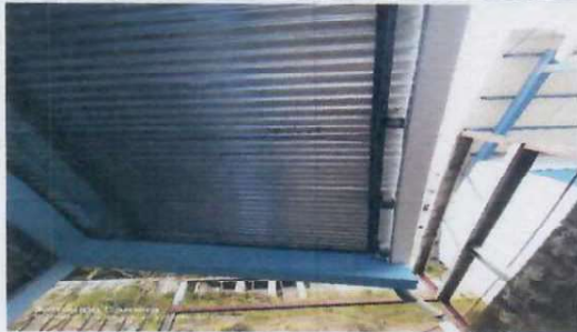
Foto 3.6 Sustrución de canal de pvc
