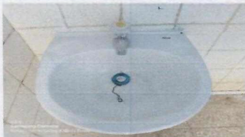
Foto 2.3 Sustitucionn de lavamanos
