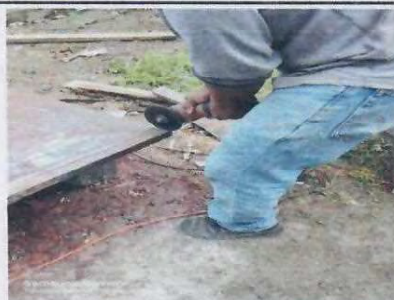
Foto sustitucion de puertas de baños
