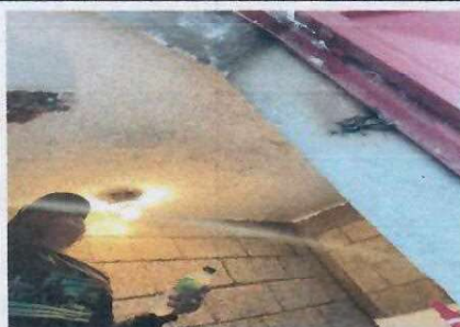
Foto 2.1: Aplicación de repello en baños
