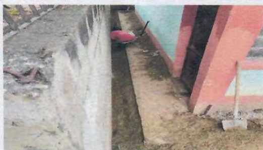
Foto 3.4 Reparacion de cuneta de concreto
