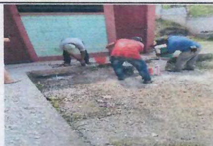
Foto 3.5 Reparación de vanqueta de concreto
