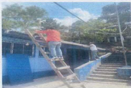
Foto 3.6 sustitución de canal de Pvc
