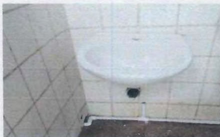
Foto 2.3 sustitucion de lavamanos
