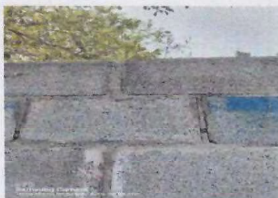
Foto 3.1 reparacion de muro perimetral de block
