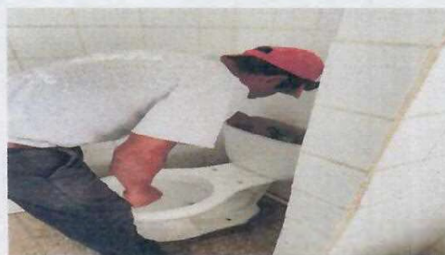
Foto 2.2 Sustitucion de inodoros
