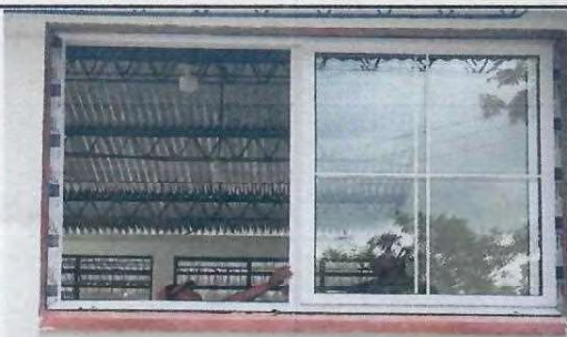
Foto 3.2 sustitución de ventanas de metal por ventanas de pvc
