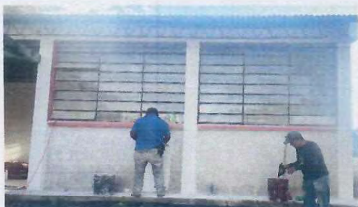
Foto 1.1 Aplicación De repello en aula
