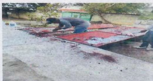
Foto 1. 2 Mantenimiento estructura ( lijado, Cambio de tubo, Cepillado,Sujeciones, aplicación de pintura) en puertas del aula
