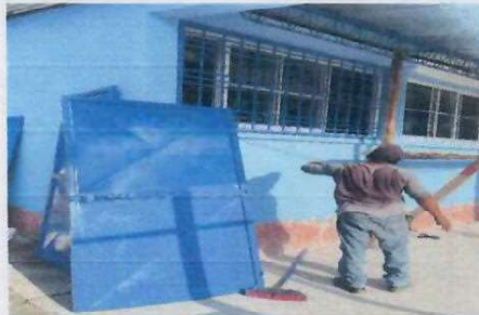
Foto 3.7 sustitución de vancones de metal
