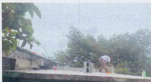
Foto 2.5 impermeabilización de loza
