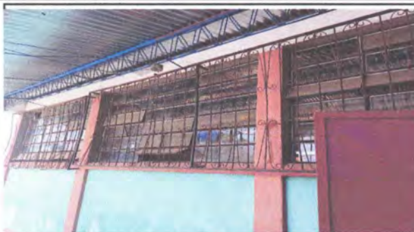
Foto 3:7 Sustitución de balcones de metal
