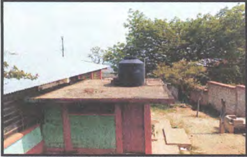
FOTO 2.5 Impermeabilización de losa
