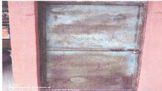
Foto 1.2 Mantenimiento a estructura(lijado, cambio de tubo, cepillado, sujeciones, aplicación de pintura) en puertas de aula.
