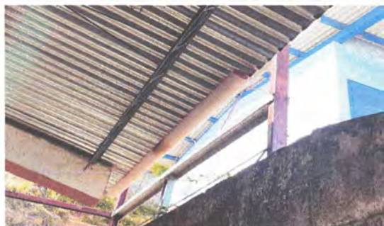
Foto 3:6 Sostitucion de canal de pvc
