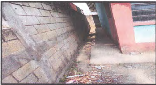
FOTO 3.4 Reparación de cuneta de concreto
