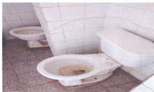
Foto 2.2 Sustitución de inodoros
