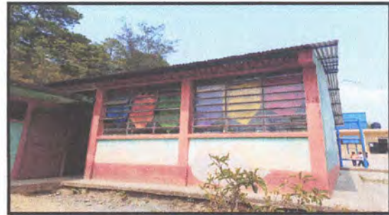
FOTO 3.3 Pintura en muros exteriores e interiores
