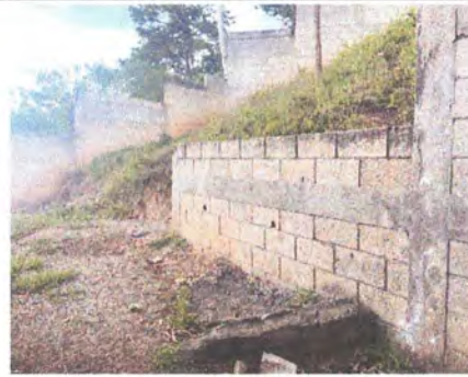
FOTO 3.1 Reparación de muro perimetral de block
