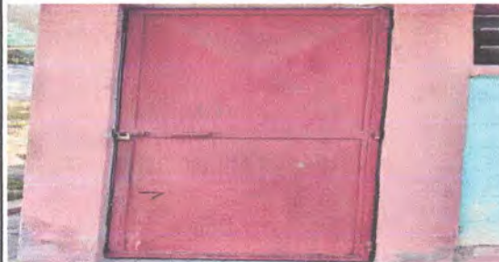
Fotos 2.3 Sustitución de puerta en baños
