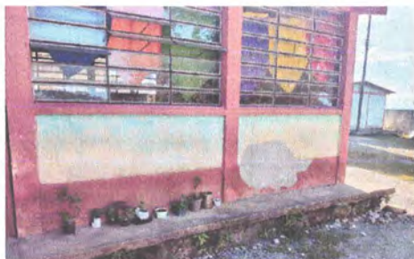
Foto 1.1 Ampliación de repello en aula
