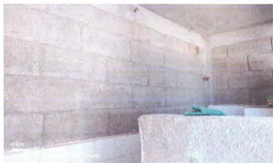
Foto 2.1 Aplicación de repello en baños
