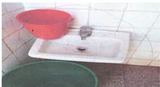
Foto 2.3 Sustitución de lavamanos
