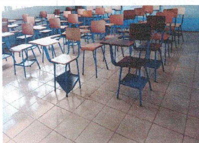
Foto 5: Renglón No. 3 Piso: 3.1 Sustitución de piso cerámico: Fotografía tomada después del remozamiento.
