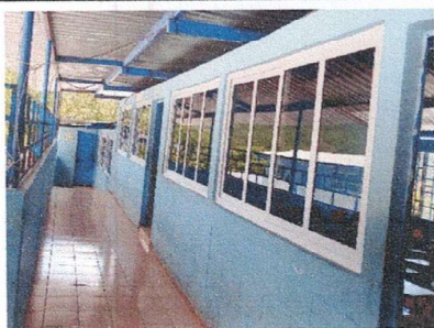
Foto 3: Renglón No. 2 Ventanas 2.1 Sustitución de ventanas de metal y vidrio por ventanales de pvc y vidrio.. Fotografía tomada después de la ejecución del remozamiento.
