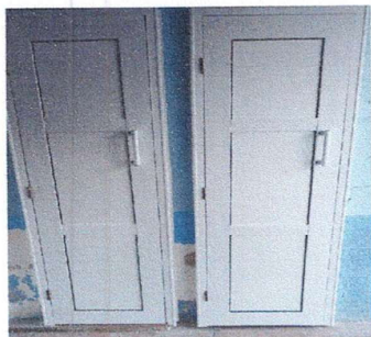
Foto1: Renglón No. 1 Puertas de metal: 1.1 Sustitución de puertas de metal por puertas de pvc. Fotografía tomada después del remozamiento.
