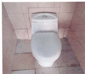
Foto 4: Renglón No. 4.2 Sustitución de inodoros. Fotografía tomada después del del remozamiento.
