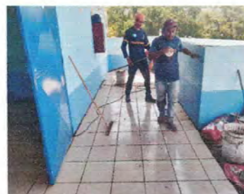
Foto 6: Renglón No. 3 Piso: 3.1 Sustitución de piso cerámico: Fotografía tomada durante el remozamiento.
