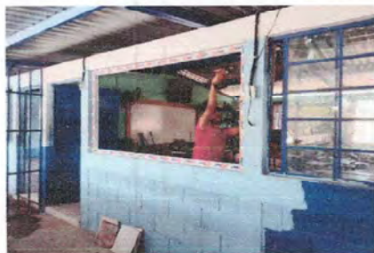
Foto 3: Renglón No. 2 Ventanas 2.1 Sustitución de ventanas de metal y vidrio por ventanales de pvc y vidrio.. Fotografía tomada Durante la ejecución del remozamiento.
