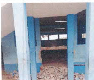
Foto 9: Fotografía de la demolición de 3 metros cuadrados de demolición en nuevo renglón de trabajo
