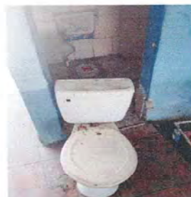
Foto 8: Renglón No. No. 4 Mano de obra Especializada de albañilería: 4.2 Sustitución de inodoros (3) unidades. Fotografía tomada durante el remozamiento.
