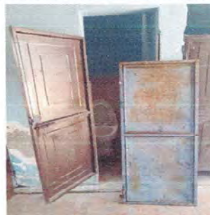
Foto 2: Renglón No. 1 Puertas de metal: 1.1 Sustitución de puertas de metal por puertas de pvc. Fotografía tomada durante el remozamiento.
