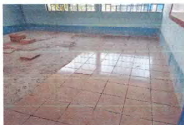
Foto 5: Renglón No. 3 Piso: 3.1 Sustitución de piso cerámico: Fotografía tomada durante el remozamiento.
