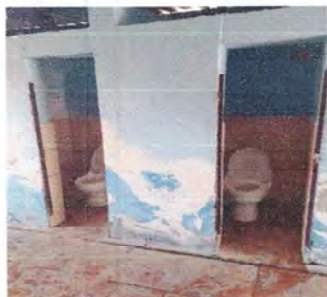
Foto 1: Renglón No. 1 Puertas de metal: 1.1 Sustitución de puertas de metal por puertas de pvc. Fotografía tomada durante el remozamiento.
