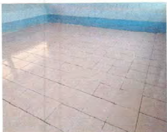
Foto 7: Renglón No. 4 Mano de obra Especializada de albañilería: 4.1 Instalación de Piso Cerámico. Fotografía tomada durante el remozamiento.
