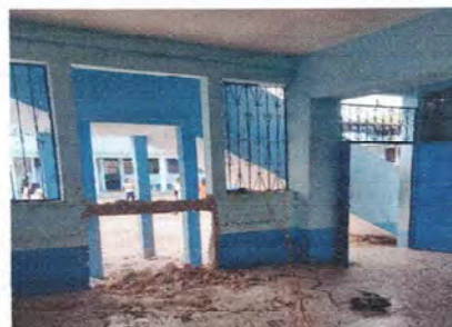
Foto 10: en la demolición de de 3, metros cuadrados de demolición y remoción de puerta de aula de salón de usos múltiples.
