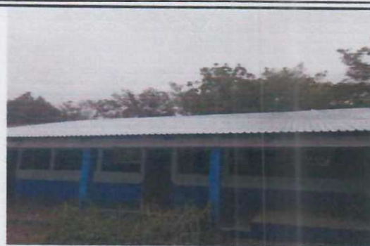
Foto 2: cambio de lámina.
