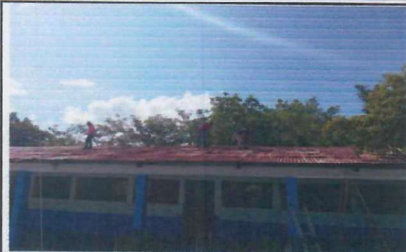
Foto 1: techo en al estado
