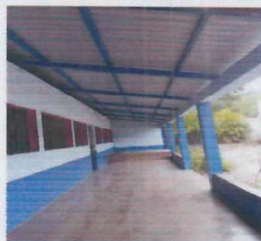
Foto 4: cambio de estructura de madera por metal y lámina en corredor.
