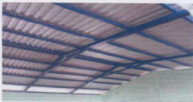
Foto 3: finalización de cambio de estructura de madera por metal y lámina en aulas
