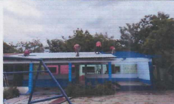
Foto 2: colocando la lámina.
