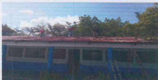
Foto1: quitando el techo
