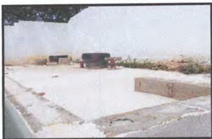
Foto 15: Sustitución de banqueta de concreto
