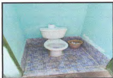
Foto 11: Sustitución de accesorios inodoro (contra llave, tubo de abasto y tanque)
