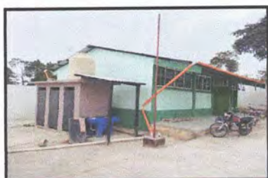
Foto 9: Sustitución de focos ahorradores
