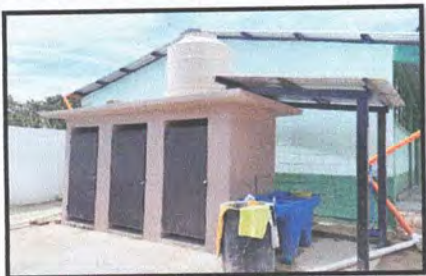
Foto 13: Aplicación de pintura en puertas de baños
