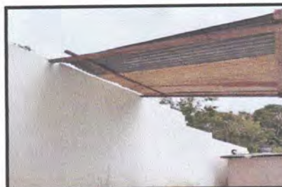
Foto 22: Sustrucción de lámina, por lámina troquelada aluzinc calibre 26 en área de juegos
