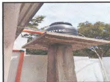
Foto 12: Sustitución de llave de cheque
