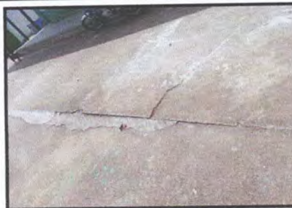
Foto 14: Sustitución de planchas de concreto en patio
