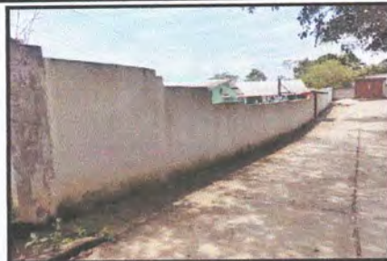
Foto 16: Pintura en muros exteriores e interiores
