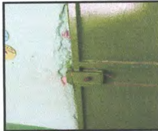
Foto 2: Sustitución de chapa de puerta en aula
