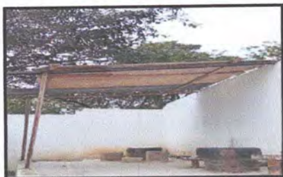
Foto 21: Sustrucción de estructura de soporte de madera por metal en área de juegos
