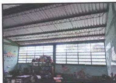
Foto 8: Sustitución de plafoneras
