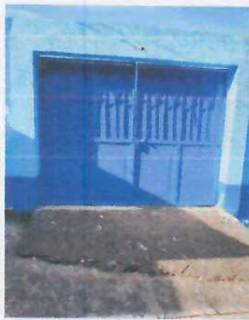
Foto 1: Reparación de portón finalizado
