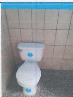
Foto 5: Reparación de la palanca del baño
