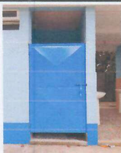
Foto 3: Reparación de puerta del baño
