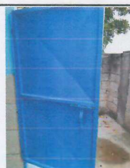
Foto 6: Reparación del pasador y pintura de la puerta de los baños.
