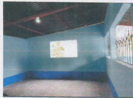
Foto 2: Terminación de la instalación de piso
