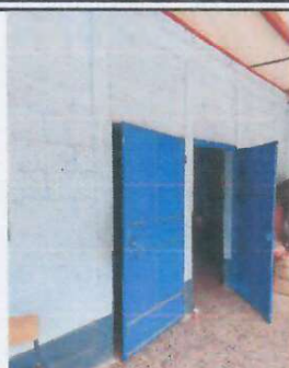
Foto 2: Finalización de cambio de reparación y posición de puertas
