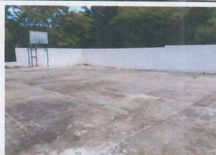
Foto 6: Finalización de Monocapa o repello en muro perimetral
