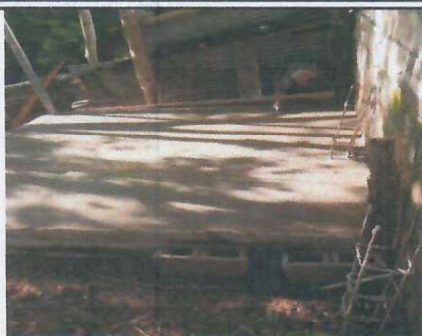
Foto 1: Finalización de encementado.
