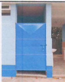
Foto 3: Reparación del pasador lado exterior de la puerta del baño
