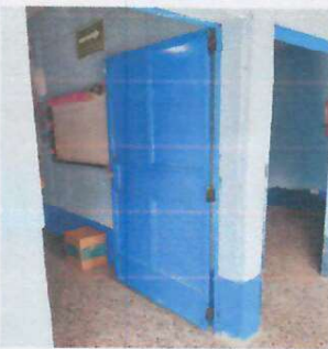
Foto 5: Terminación de la reparación de puertas
