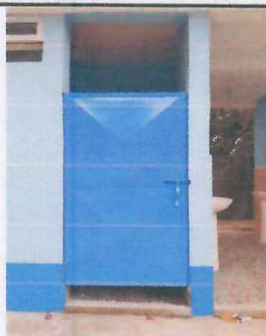
Foto 1: Alargamiento de la puerta del baño
