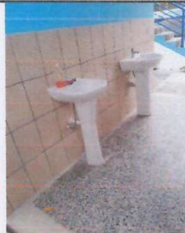
Foto 4: Reparación de lavamanos
