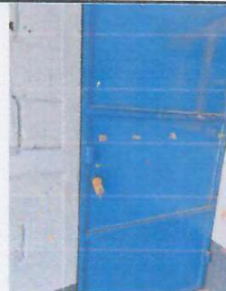
Foto 4: Cambio de chapa
