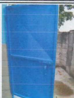
Foto 2: Reparación del pasador lado interior de la puerta del baño
