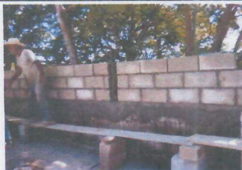
Foto 4: Continuidad de muro perimetral
