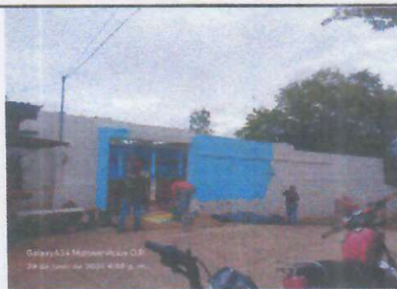
Foto 6: Aplicación de pintura externa.
