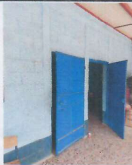
Foto 2: Aplicación de Monocapa o repello en muro perimetral
