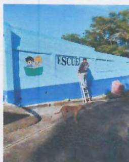
Foto 3: Colocacion de letras que identifiquen al establecimiento
