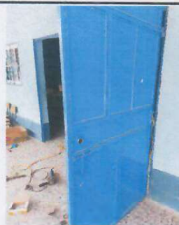
Foto 6: Colocación de la puerta.
