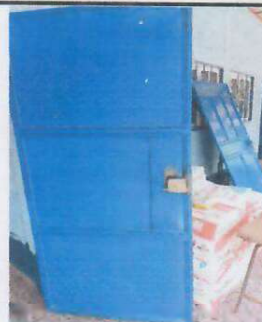
Foto 4: Colocación de puertas
