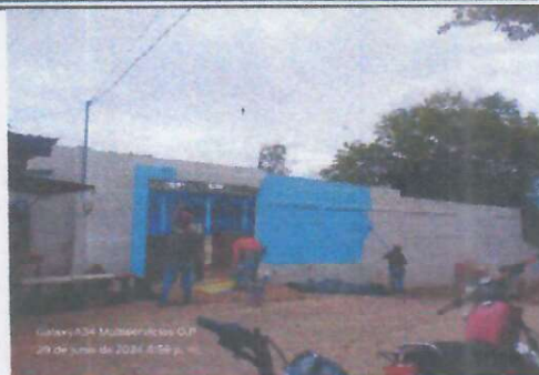
Foto 2: Aplicación de Monocapa o repello en muro perimetral
