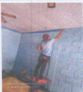
Foto 5: Aplicación de pinturas en muros
