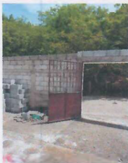
Foto 3: Durante la reparación del portón
