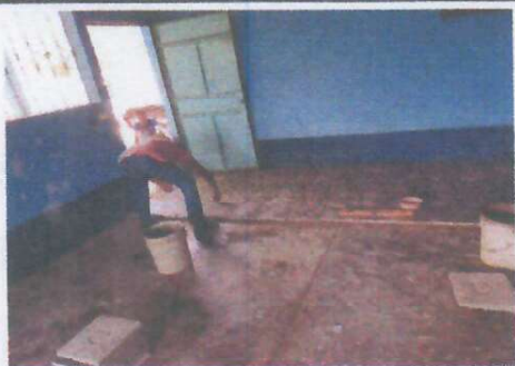
Foto1: Durante la Instalación de piso.
