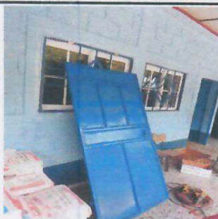
Foto 5: Cambio de posición de puertas.
