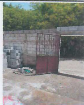
Foto 2: Durante la reparación del portón
