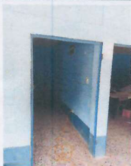
Foto 1: Durante la reparación de puerta de aula
