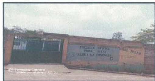
Foto 9: Mantenimiento de portón de metal
