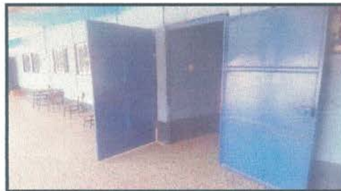
Foto 8: Sustitución de chapa de puertas en aulas
