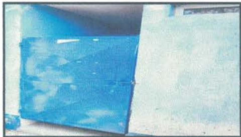
Foto 7: Mantenimiento a estructura (lijado, cambio de tubo, cepillado, sujeciones, aplicación de pintura) en puertas
