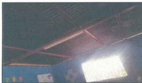
Foto 2: Reparación de lámparas
