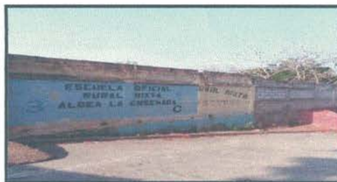
Foto 4: Reparación de muro perimetral de block.
