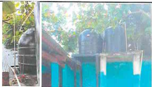
Foto 5: SUSTITUCION O INSTALACION DE DEPOSITO PARA AGUA DE 1100LTS.
