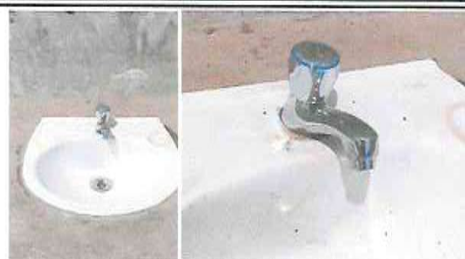
Foto 8: SUSTITUCION DE ACCESORIOS DE LAVAMANOS.
