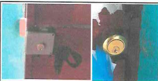
Foto 10: SUSTITUCION E INSTALACION DE CHAPAS.
