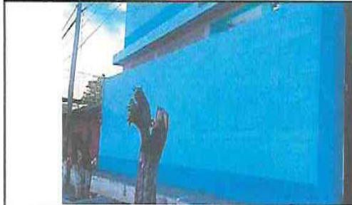
Foto 1: SUSTITUCION DE MALLA POR MAMPOSTERIA EN MURO FRONTAL EXISTENTE.
