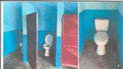
Foto 7: SUSTITUCION DE INODOROS CON ACCESORIOS y APLICACIÓN DE PINTURA EN MUROS.
