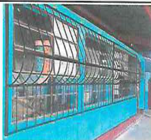
Foto 9: INSTALACION DE BALCONES.
