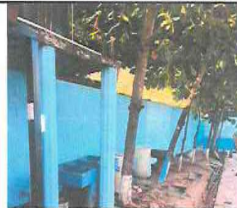
Foto 2: APLICACIÓN DE PINTURA.
