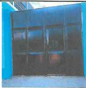
Foto 3: SUSTITUCION O INSTALACION DE PORTON DE METAL.
