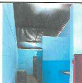
Foto 10: CAMBIO DE FOCOS.
