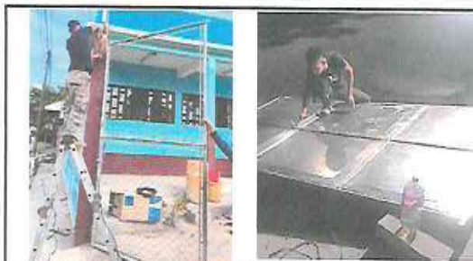
Foto 3: SUSTITUCION O INSTALACION DE PORTON DE METAL.
