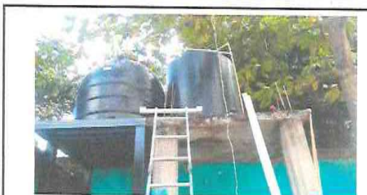
Foto 5: SUSTITUCION O INSTALACION DE DEPOSITO PARA AGUA DE 1100LTS.
