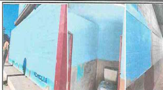
Foto 2: APLICACIÓN DE PINTURA.
