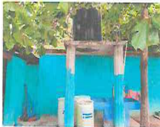
Foto 3: Sustitución de tanque y estructura de soporte metalico y cambio de linea principal de agua potable.
