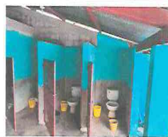
Foto 4: Sustitución de inodoros y lavamanos en area de baños.
