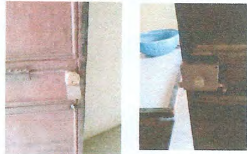
Foto 14: Cambio de chapa en puerta metal en cocina.
