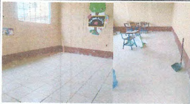
Foto 1: Instalacion de piso ceramico en aulas.
