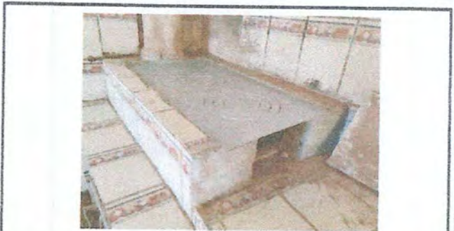
Foto 10: Sustitución de plancha de metal de 3 hornillas y ampliación de Estufa Rural.
