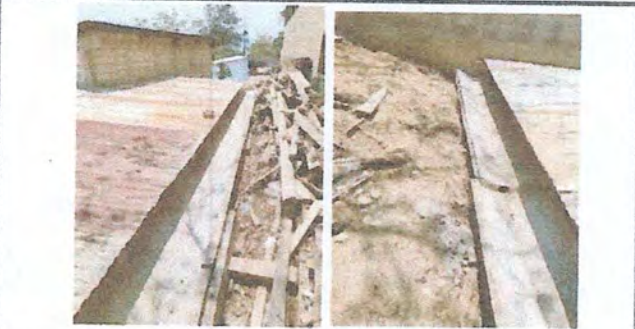
Foto 9: Fundición de cuneta de concreto para protección de muro de contención.
