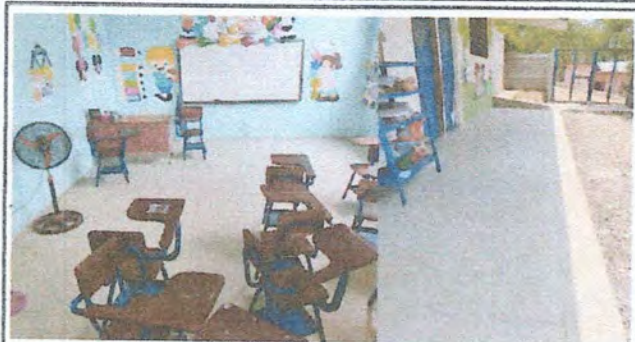
Foto 2: Instalacion de piso ceramico en aulas.
