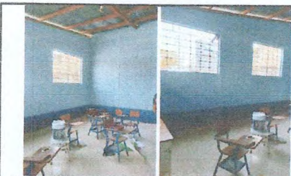
Foto 4: Aplicación de pintura en interior de aulas.
