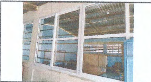
Foto 5: Instalacion de ventaneria de PVC.
