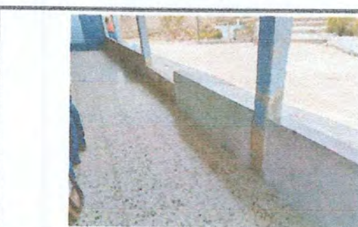
Foto 6: Sustitucion de muro tipo pretil.
