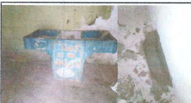
Foto 9: Reubicación de pila en cocina.
