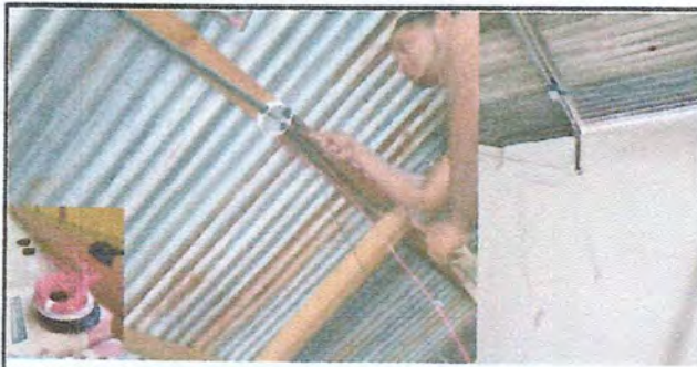
Foto 6: Instalación unidad de iluminación y fuerza en bodega y cocina.
