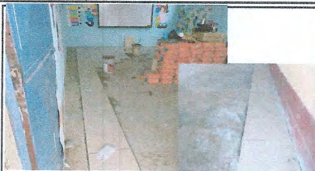
Foto 1: Instalación de piso cerámico en aulas.
