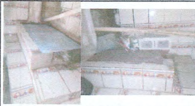
Foto 8: Sustitución de plancha d de metal de 3 hornillas y ampliación de Estufa Rural.
