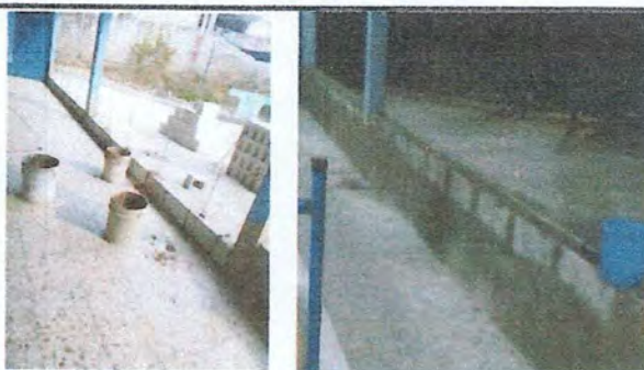
Foto 4: Sustitución de muro tipo pretil.
