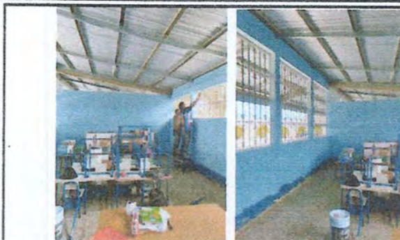
Foto 2: Aplicación de pintura en interior de aulas.
