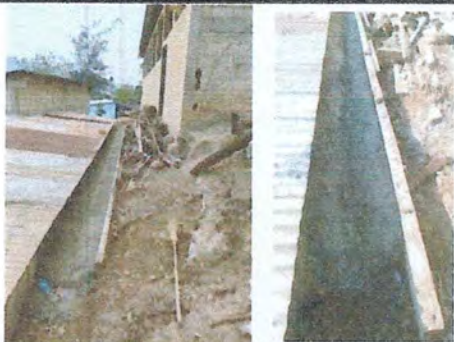
Foto 7: Fundición de cuneta de concreto para protección de muro de contención.
