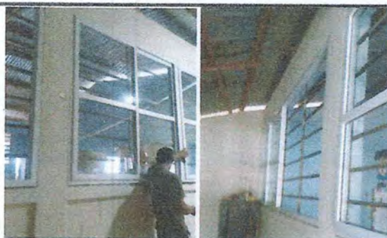
Foto 3: Instalación de ventanería de PVC.
