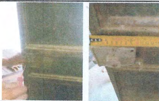
Foto 11: Cambio de chapa en puerta metal en cocina.
