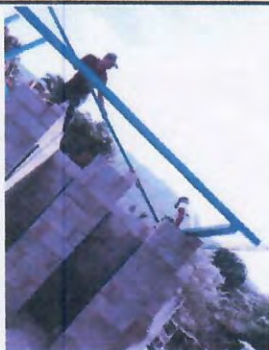
Foto 7: ESTRUCTURA METALICA Y LAMINA EN SERVICIOS SANITARIOS
