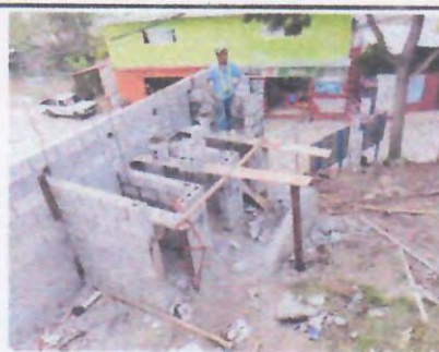
Foto 6: MURO TABIQUE SERVICIOS SANITARIOS
