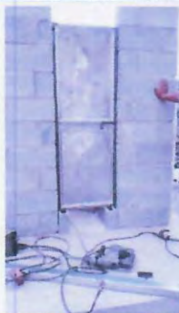
Foto 9: COLOCACION DE PUERTAS EN SERVICIOS SANITARIOS
