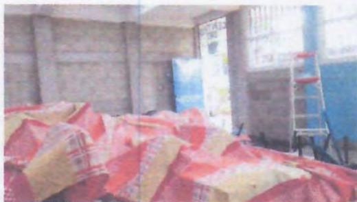
Foto 3: APLICACIÓN DE PINTURA
