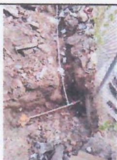
Foto 5: INSTALACION DE TUBERIA DE DRENAJE Y AGUA POTABLE
