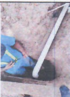
Foto 5: INSTALACION DE TUBERIA DE DRENAJE Y AGUA POTABLE
