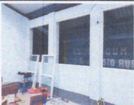
Foto 1: INSTALACION DE VENTANAS DE PVC
