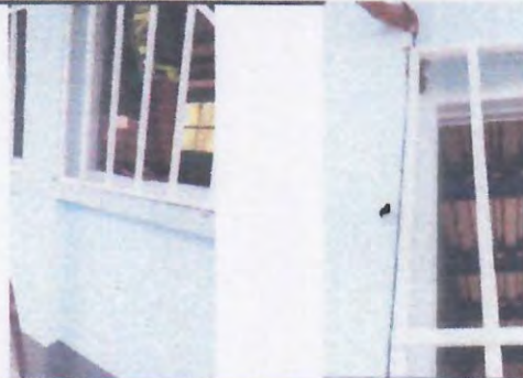
Foto 2: INSTALACION DE BALCONES METALICOS
