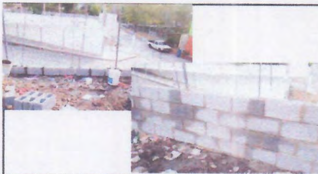
Foto 4: SUSTITUCION DE MURO PERIMETRAL DE MALLA POR TIPO BLOCK
