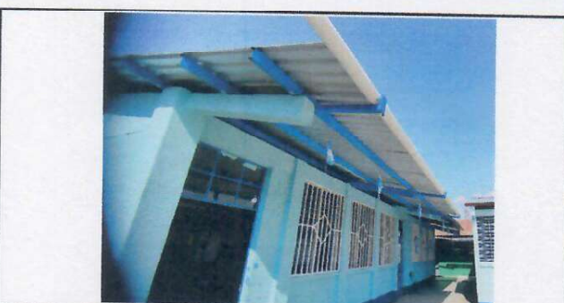
Foto 11: INSTALACION DE CANAL TIPO TUBO PVC.
