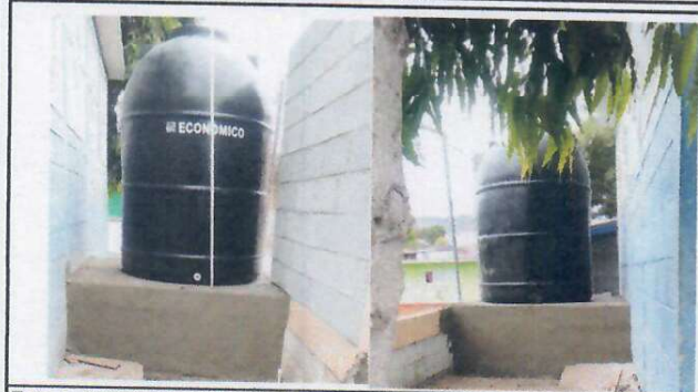
Foto 7: SUSTITUCION O INSTALACION DE DEPOSITO.
