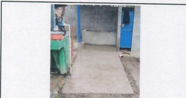
Foto 9: SUSTITUCION O INSTALACION DE PISO DE TORTA DE CONCRETO Y NIVELACION.
