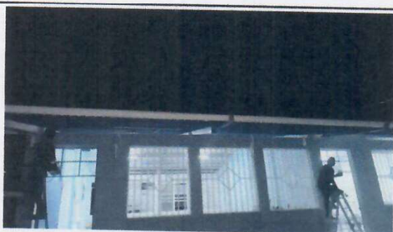
Foto 11: INSTALACION DE CANAL TIPO TUBO PVC.
