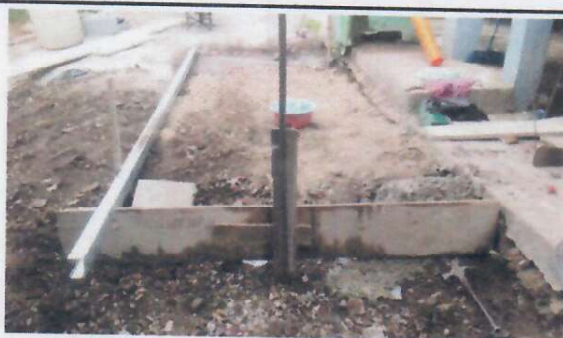
Foto 9: SUSTITUCION O INSTALACION DE PISO DE TORTA DE CONCRETO Y NIVELACION.
