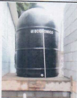
Foto 7: SUSTITUCION O INSTALACION DE DEPOSITO.
