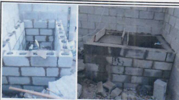
Foto 8: SUSTITUCION DE PILA DE CEMENTO, DE UN LAVADERO HECHIZA.
