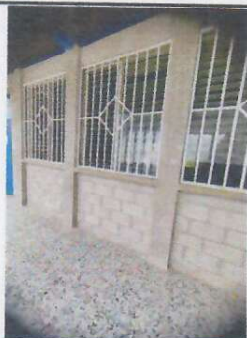
Foto 3: Mantenimiento de balcones metálicos en aulas
