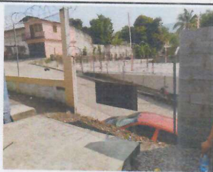
Foto 4: Sustitución de muro perimetral existente de malla por block
