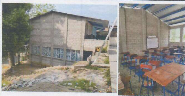
Foto 1: Pintura en paredes exteriores e interiores de aulas, como cambio de ventanería de paletas por pvc corrediza.
