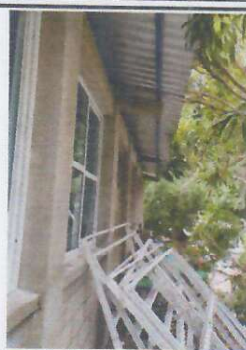
Foto 2: Instalación de lámina y estructura en techo y cerramiento vertical de galera con estructura metálica y lámina.
