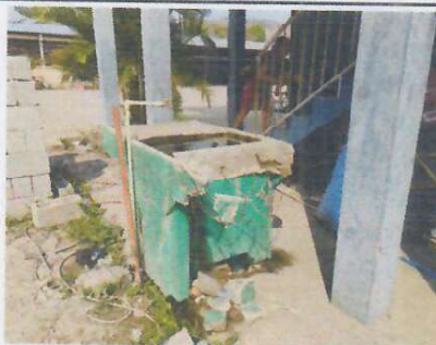
Foto 6: Sustitución de pila y piso de torta de cemento.
