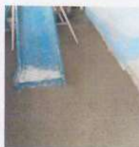
Foto 6: Sustrución de concreto en patio.
