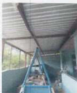
Foto 3: Sustrución de lámina en cocina.
