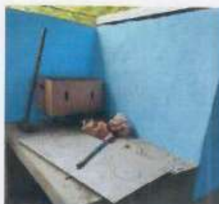
Foto 4: Sustrución de estufa rural e instalación de mueble de concreto.
