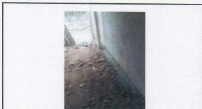
Foto 7: En la parte de atrás de esta pared se realizan los trabajos de fundición para evitar humedad.
