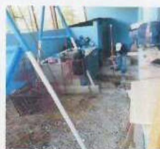
Foto 6: Sustitucion de concreto en patio.
