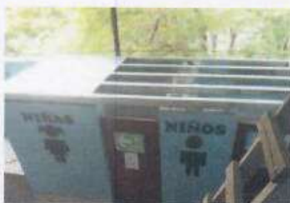
Foto 5: Sobre el baño se instalara la estructura de metal para el deposito de agua.
