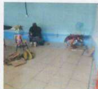
Foto 2: Sustitución o instalación de piso cerámico.
