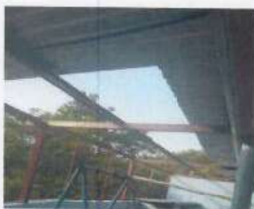
Foto 3: Sustitución de lámina en cocina.
