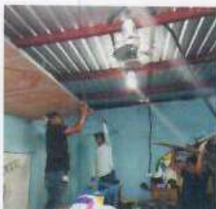
Foto1: Sustitución o instalación de cielo falso
