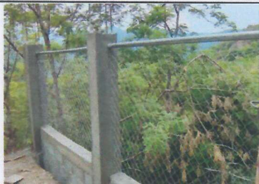
Foto 3: SUSTITUCION DE MALLA GALVANIZADA Y MURO PERIMETRAL.
