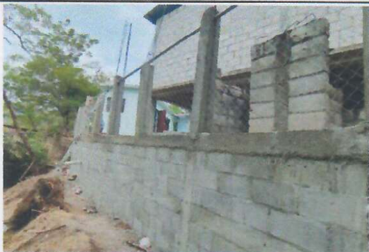
Foto 1: DEMOLICION DE MURO DE CONTENCION Y EXTRACCION DE RIPIO.
