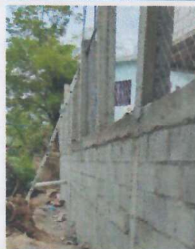
Foto 2: SUSTITUCION DE MURO PERIMETRAL.
