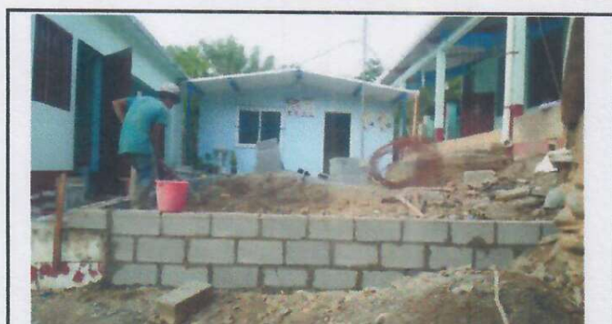
Foto 4: SUSTITUCION O INSTALACION DE PISO DE TORTA DE CEMENTO.
