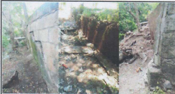
Foto 1: DEMOLICION DE MURO DE CONTENCIÓN Y EXTRACCIÓN DE RIPIO.
