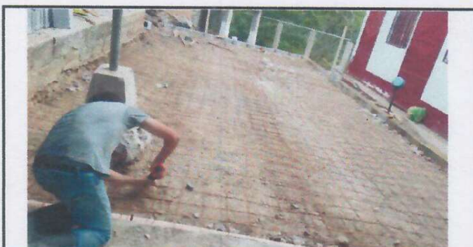
Foto 5: SUSTITUCION O INSTALACION DE PISO DE TORTA DE CEMENTO.
