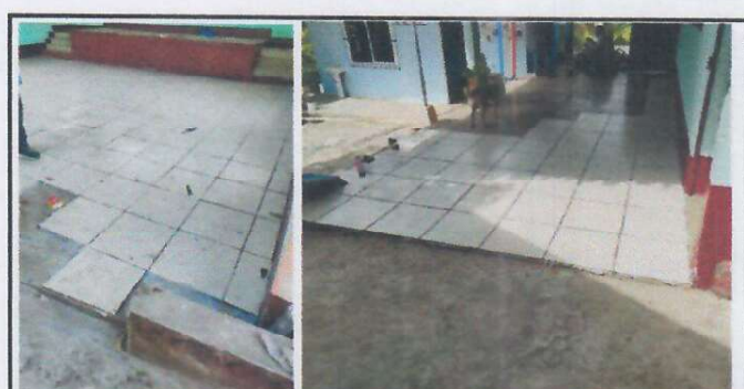
Foto 6: SUSTITUCION O INSTALACION DE PISO CERAMICO.
