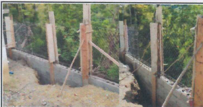
Foto 3: SUSTITUCION DE MALLA GALVANIZADA Y MURO PERIMETRAL.
