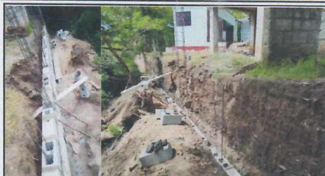
Foto 2: SUSTITUCION DE MURO PERIMETRAL.
