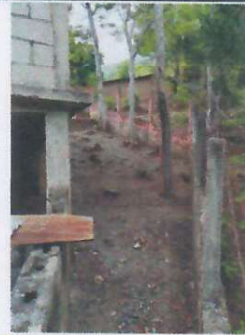
Foto 2: Sustitución de malla en muro perimetral.
