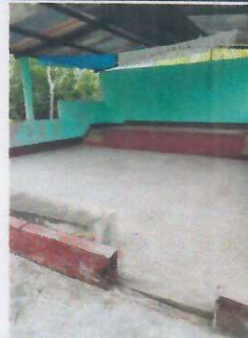
Foto 4: Instalación de piso cerámico.
