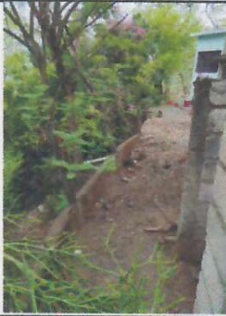
Foto 1: Demolición y Reparación de muro perimetral deteriorado.
