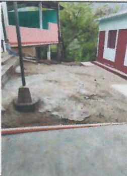
Foto 3: Instalación de piso de torta de Cemento en patio central.
