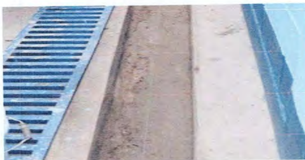
Foto 8: Instalación de Drenaje Pluvial
