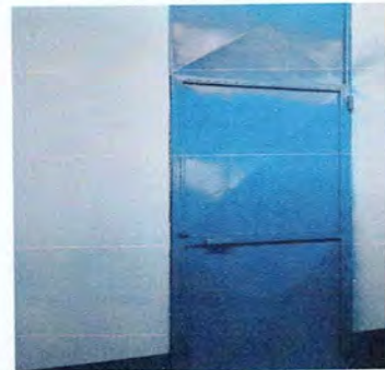
Foto 4: Mantenimiento de Puertas, lijado, pintura y reforzamiento de marco.
