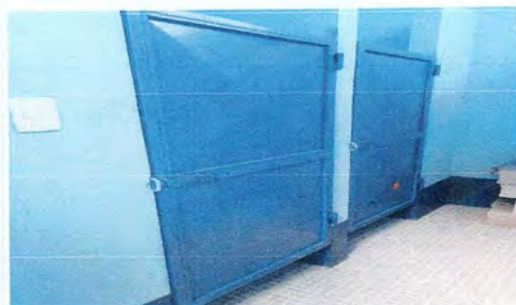
Foto 6: Remozamiento de puertas en baños, lijado, pintura y refrezamiento de marco
