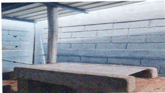
Foto 9: Construcción de Estufa Rural Completa
