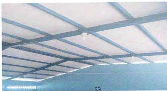
Foto 5: Instalación de Luminarias( Alambre, Bombillas y cable)
