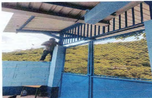
Foto 10: Mantenimiento de porton principal y se agregará un metro de altura
