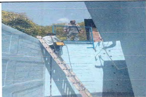
Foto 11: Colocación de Tubo Hg y malla Galbanizada sobre muro perimetral ubicada en la parte de atrás de la escuela
