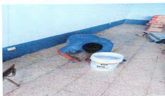
Foto 2: Mantenimiento de piso de granito
