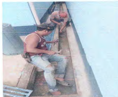
Foto 8: Instalación de Drenaje Pluvial
