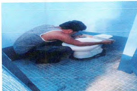
Foto7: Cambio de Inodoros
