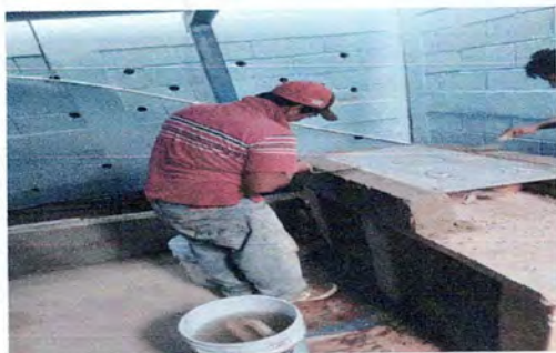
Foto 9: Construcción de Estufa Rural Completa
