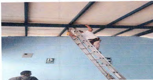
Foto 5: Instalación de Luminarias( Alambre, Bombillas y cable)
