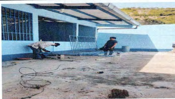
Foto 3: Mantenimiento de sedazo en balcones
