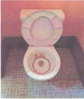
Foto 7: Cambio de Inodoros
