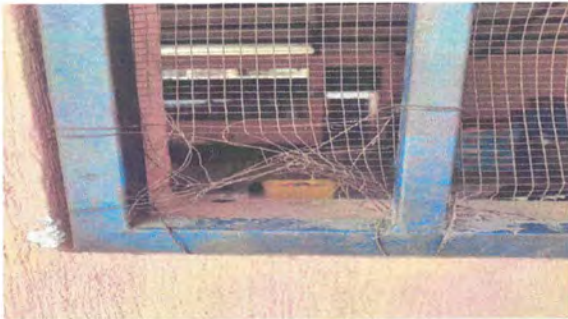
Foto 3: Mantenimiento de sedazo en balcones
