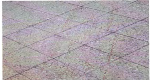
Foto 2: Mantenimiento de piso de granito
