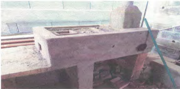
Foto 9: Construcción de Estufa Rural Completa
