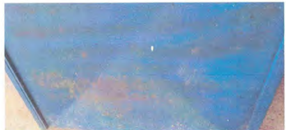
Foto 6: Remozamiento de puertas en baños, lijado, pintura y refrozamiento de marco
