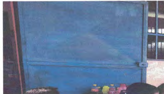
Foto 4: Mantenimiento de Puertas, lijado, pintura y reforzamiento de marco.
