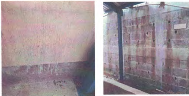
Foto1: Pintura en muros, en interiores y exteriores
