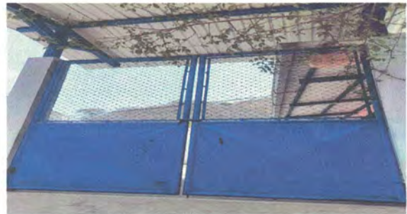
Foto 10: Mantenimiento de porton principal y se agregará un metro de altura
