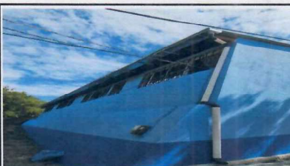
Foto 6: Instalación de Canal de metal con bajada de agua.
