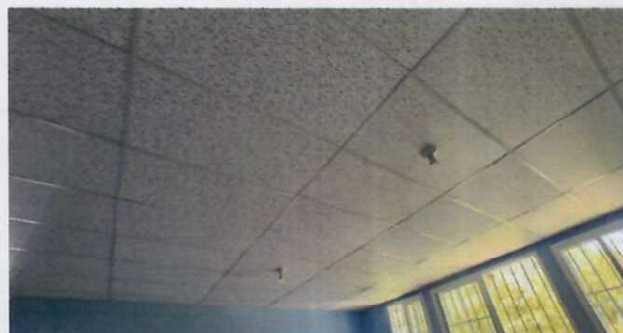
Foto 4: Instalación de cielo falso en todas las aulas.
