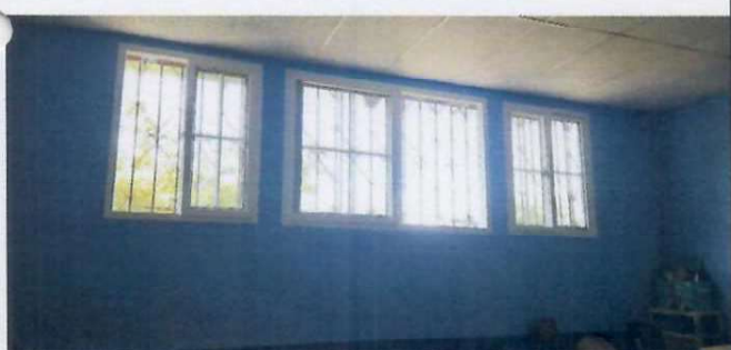
Foto 5: Instalación de ventanas PVC correrizas en tres aula y dirección.
