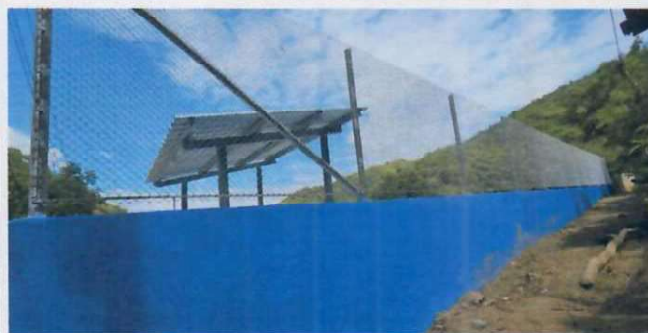
Foto 2: Reparación de tubo hg y malla galvanizada. Sustituida en su totalidad.
