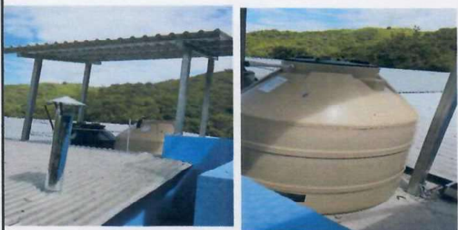
Foto 3: Recipiente de agua sustituido y con mejoras para su protección.
