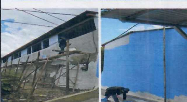
Foto 6: Preparación para instalar Canal de metal con bajada de agua.
