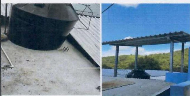
Foto 3: Reparación de losa para colocar el depósito de agua sustituido y con mejoras para su protección.
