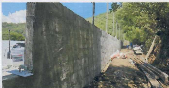
Foto 2: Preparación de muro perimetral para sustituir en su totalidad tubo hg y malla galvanizada.
