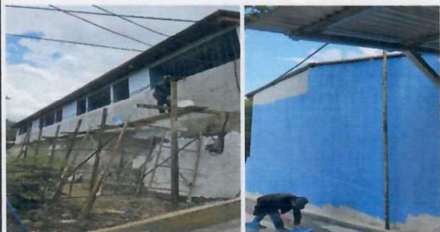
Foto1: Reparación en muros exteriores e interiores, para poder pintar en su totalidad.
