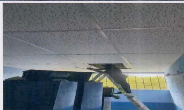
Foto 4: Proceso de instalación de cielo falso en todas las aulas.
