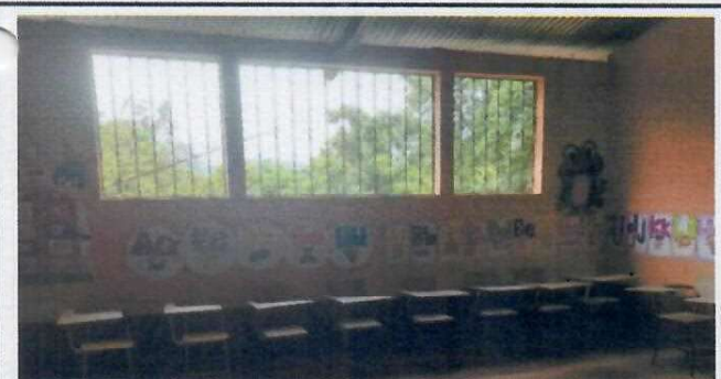
Foto 5: Ventanas de aulas solo con balcon, se instalaran ventanas PVC correrizas
