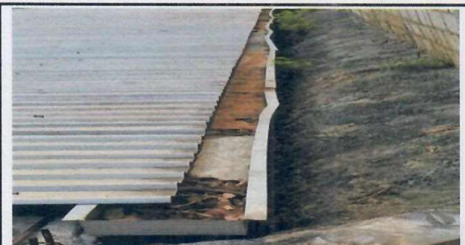
Foto 6: Canal de metal con varias perforaciones, será sustituido y mejorado
