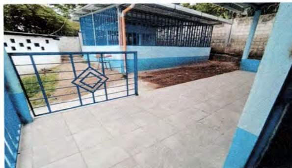
Foto 6: Instalación de piso cerámico
