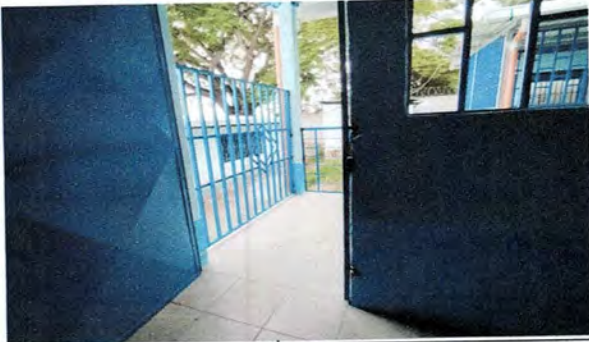
Foto 1: Instalación de Puerta
