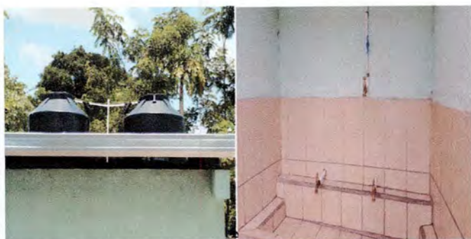
Foto 5: Instalación de accesorios depósito de agua y red de agua.
