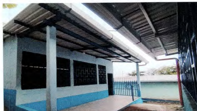
Foto 4: Instalación de canal de Metal
