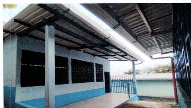
Foto 4: Instalación de canal de Metal
