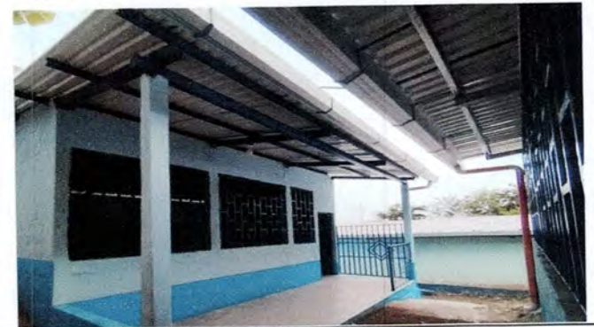
Foto 4: Instalación de canal de Metal
