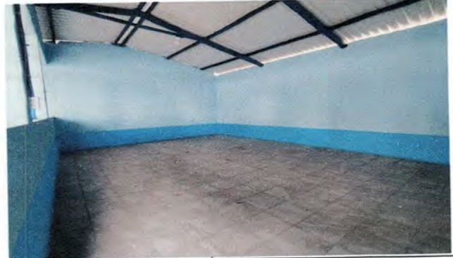
Foto 2: Pintura en muros de interiores
