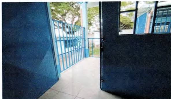
Foto 1: Instalación de Puerta
