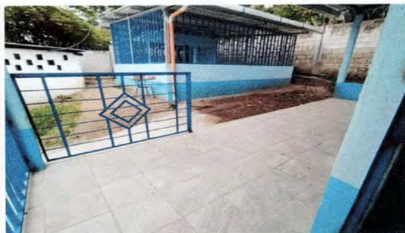
Foto 6: Instalación de piso cerámico
