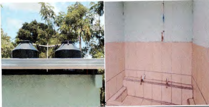
Foto 3: Instalación de accesorios depósito de agua y red de agua.
