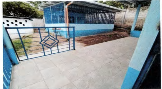
Foto 6: Instalación de piso cerámico
