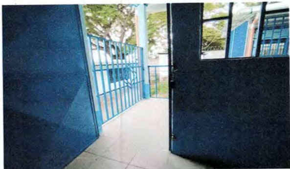
Foto 1: Instalación de Puerta
