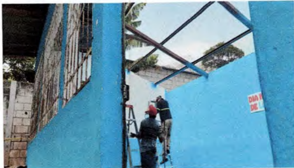
Foto 1: Mantenimiento a estructura de soporte de metal
