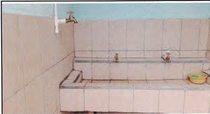
Foto 6: Sustitución de grifos
