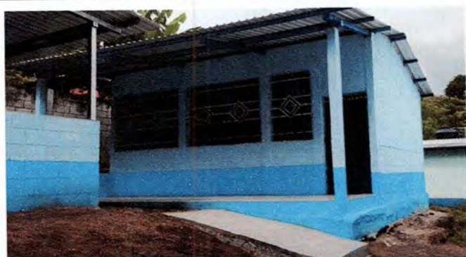
Foto 3: Reparación de gradas para acceder al aula
