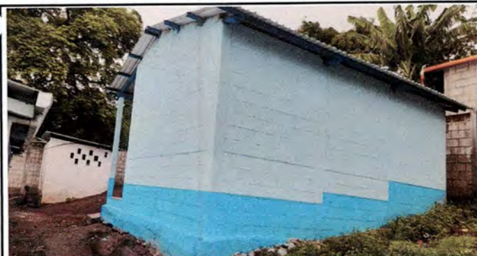
Foto 5: Pintura en muros exteriores
