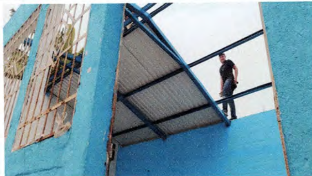
Foto 2: Instalación de lámina troquelada aluzinc
