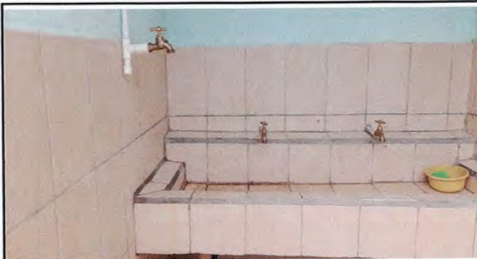
Foto 6: Sustitución de grifos
