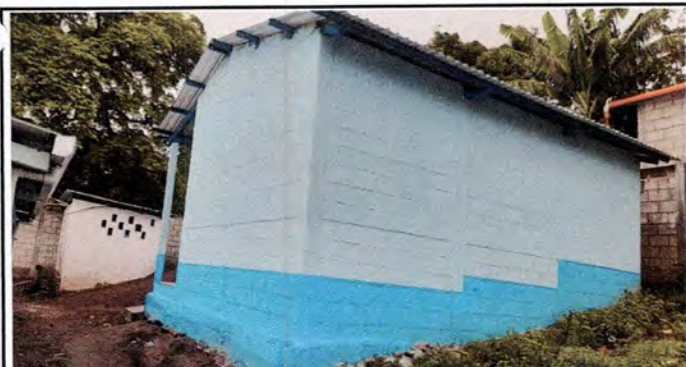
Foto 5: Pintura en muros exteriores
