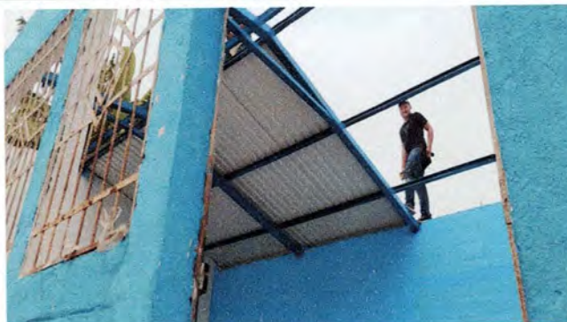
Foto 2: Instalación de lámina troquelada aluzinc
