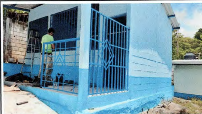
Foto 4 : Sustitución de balcones de metal
