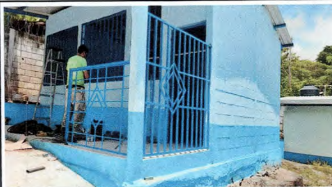
Foto 4 : Sustitución de balcones de metal
