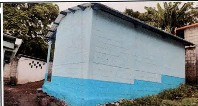
Foto 5: Pintura en muros exteriores
