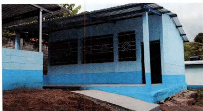
Foto 3: Reparación de gradas para acceder al aula
