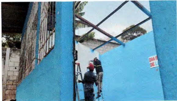
Foto 1: Mantenimiento a estructura de soporte de metal
