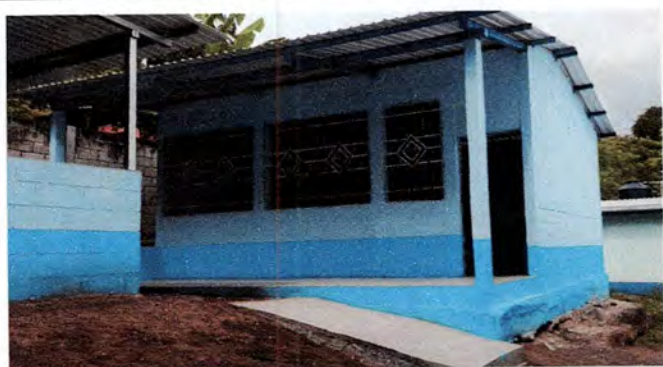
Foto 3: Reparación de gradas para acceder al aula
