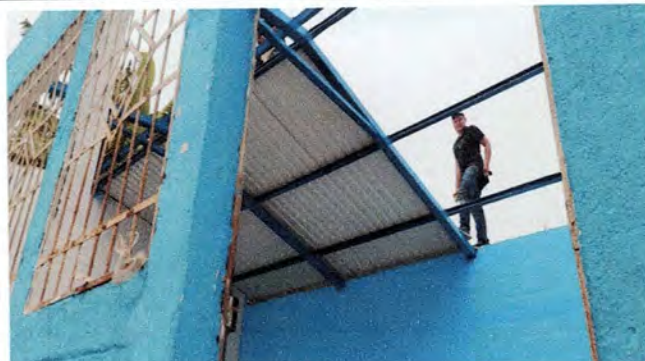
Foto 2: Instalación de lámina troquelada aluzinc
