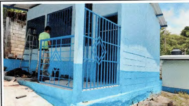
Foto 4 : Sustitución de balcones de metal
