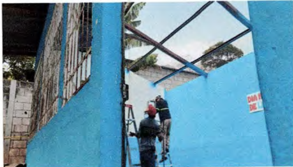
Foto 1: Mantenimiento a estructura de soporte de metal
