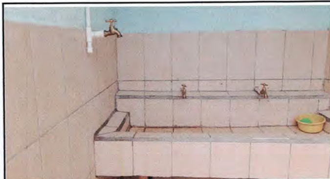
Foto 6: Sustitución de grifos
