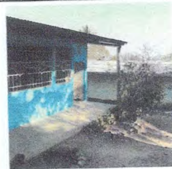
Foto 4: Reparación de Aula Pura.
