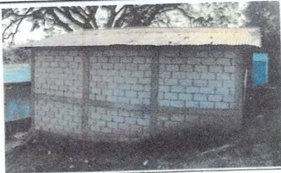
Foto 3: Reparación de Aula Pura.
