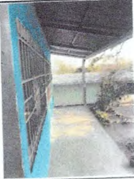
Foto 1: Reparación de Aula Pura.
