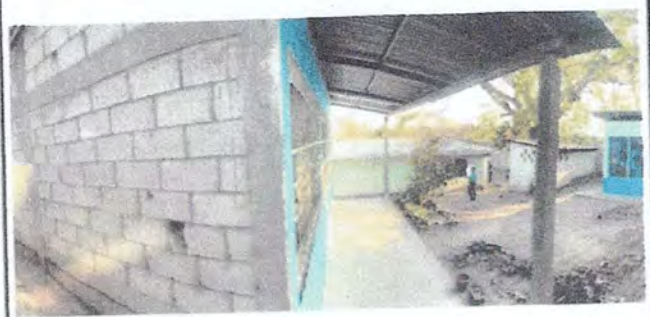
Foto 2: Reparación de Aula Pura.
