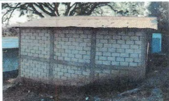
Foto 3: Reparación de Aula Pura.
