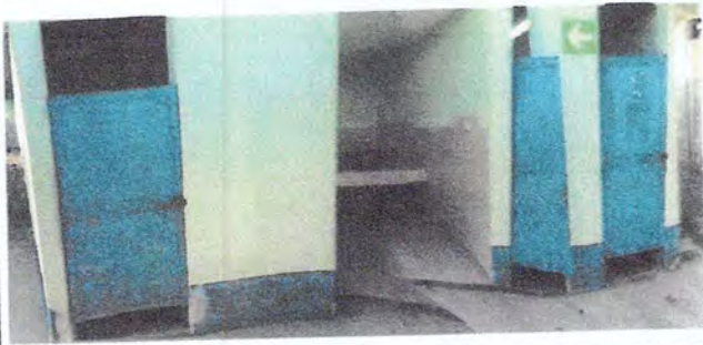
Foto 5: Reparación de Servicios Sanitarios-
