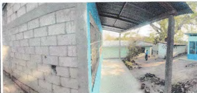
Foto 2: Reparación de Aula Pura.
