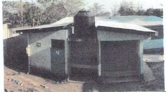
Foto 6: Reparación de Servicios Sanitarios-
