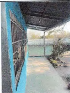
Foto 1: Reparación de Aula Pura.
