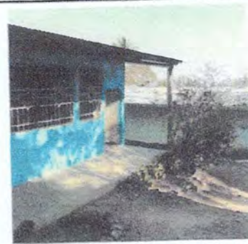
Foto 4: Reparación de Aula Pura.
