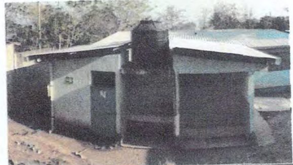
Foto 6: Reparación de Servicios Sanitarios-
