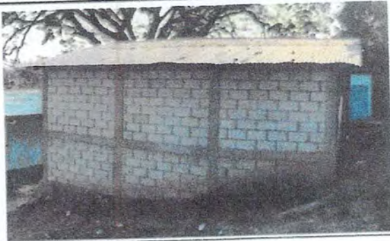
Foto 3: Reparación de Aula Pura.
