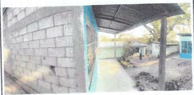
Foto 2: Reparación de Aula Pura.
