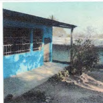
Foto 4: Reparación de Aula Pura.
