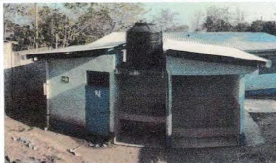
Foto 6: Reparación de Servicios Sanitarios-
