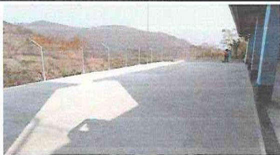
Foto 1: Muro de contención y piso en el patio
