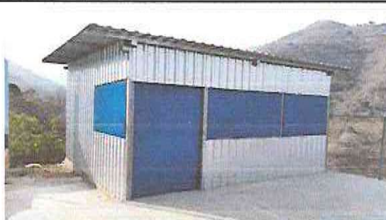
Foto 2: Mejoramiento de cocina y colocación de puerta y ventana.
