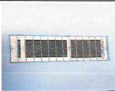
Foto 5: Instalación de Ventana
