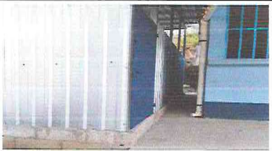
Foto 3: Cercamineto de galera con lámina
