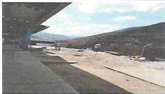
Foto 1: Instalación de piso de torta de concreto.
