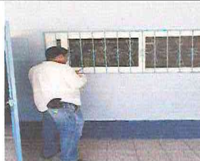
Foto 2: Instalación de ventana de PVC.
