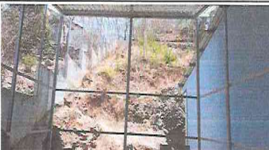
Foto 6: cercamiento de galera con estructura metálica y lámina
