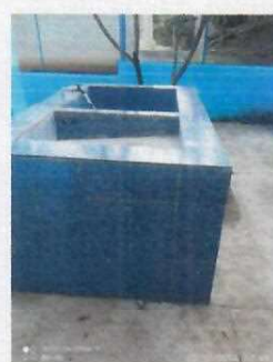
Foto 4: Instalación de Azulejo en Pila
