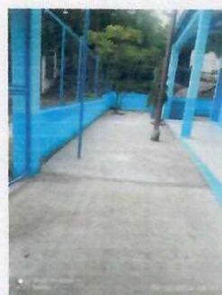
Foto 2: Sustitución de planchas de Concreto
