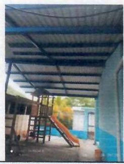
Foto 5: Instalación de estructura de soporte de techo y lámina en galera
