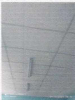
Foto 1: Instalación de Cielo Falso en Aula
