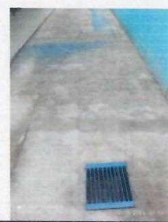
Foto 6: Instalación de Rejilla en drenaje de aguas pluviales
