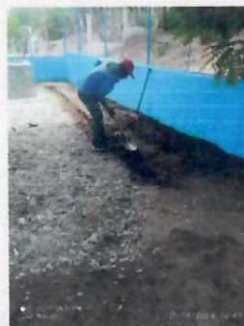
Foto 3: Zanqueo de drenaje para aguas pluviales
