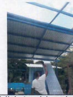
Foto 6: Instalación de lámina troquelada en galera
