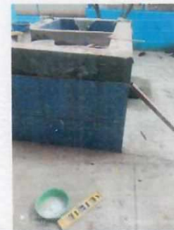
Foto 4: Instalación de Azulejo en Pila
