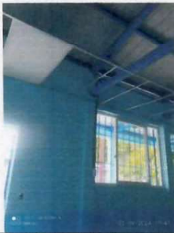
Foto1: Instalación de Cielo Falso en Aula
