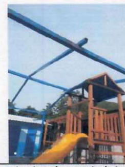
Foto 5: Instatación de estructura de soporte de techo para galera
