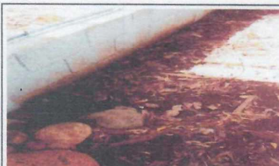
Foto 5: Repellos y cernidos en muro perimetral.
