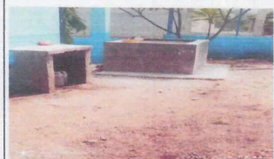
Foto 4: Sustitución de pila de concreto
