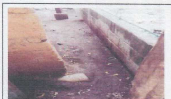
Foto 5: Repellos y cernidos en muro perimetral.
