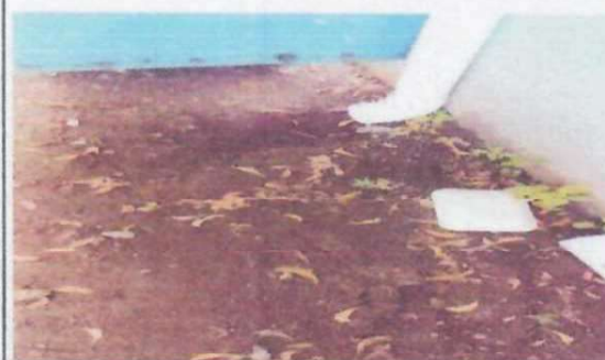
Foto 3: Instalación de drenaje de aguas pluviales e instalación de rejillas.
