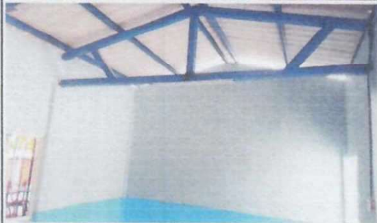
Foto 1: Instalación de cielo falso.
