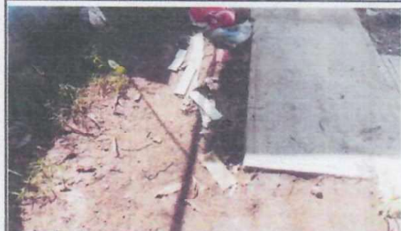
Foto 2: Sustitución de planchas de concreto en patio.
