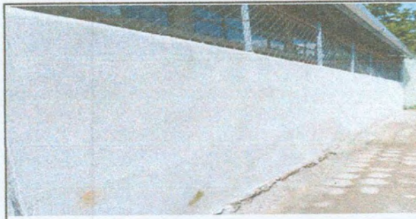
Foto 6: REPELLO MURO PERIMETRAL
