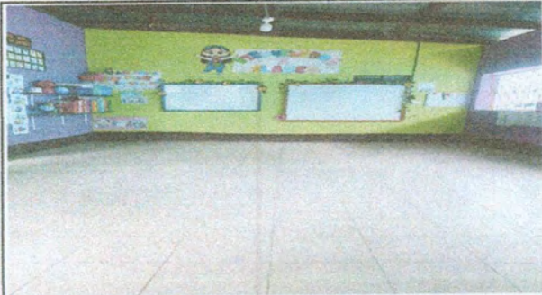
Foto1: INSTALACIÓN DE PISO CERÁMICO EN AULAS
