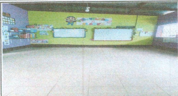
Foto 1: INSTALACION DE PISO CERÁMICO EN AULAS
