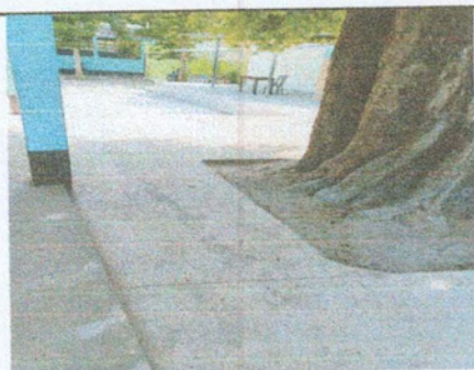
Foto 9: SUSTITUCION DE PLANCHAS DE CONCRETO DE PATIO
