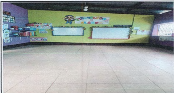
Foto1: INSTALACION DE PISO CERÁMICO EN AULAS
