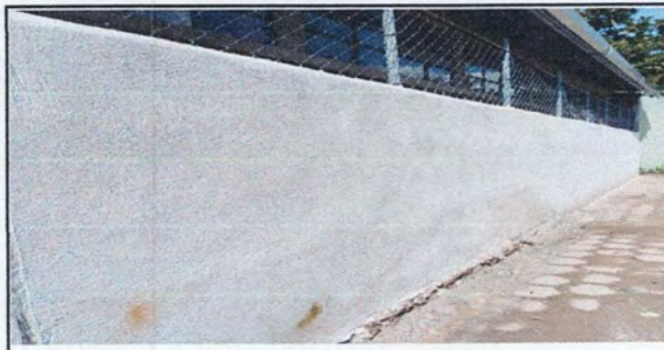
Foto 6: REPELLO MURO PERIMETRAL
