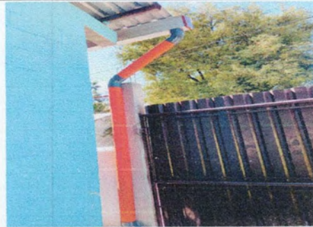
Foto 8: INSTALACIÓN DE TUBERIA PVC EN LÍNEA PRINCIPAL DE AGUA PLUVIAL
