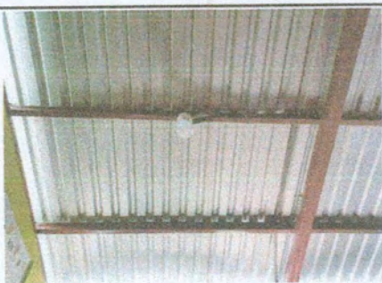
Foto 3: SUSTITUCION DE LUMINARIA (PLAFONERA, FOCO, ALAMBRADO Y DUCTO)
