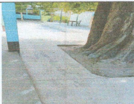
Foto 9: SUSTITUCION DE PLANCHAS DE CONCRETO DE PATIO
