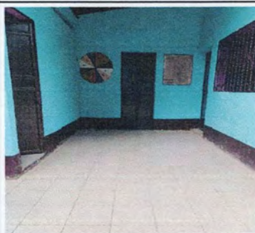
Foto 2: INSTALACION DE PISO CERÁMICO EN AULAS
