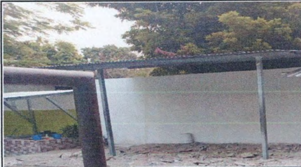
Foto 7: CERNIDO EN MURO PERIMETRAL
