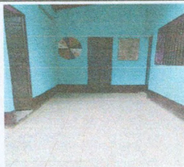
Foto 2: INSTALACION DE PISO CERÁMICO EN AULAS
