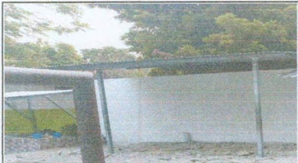
Foto 7: CERNIDO EN MURO PERIMETRAL
