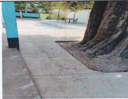
Foto 9: SUSTITUCION DE PLANCHAS DE CONCRETO DE PATIO
