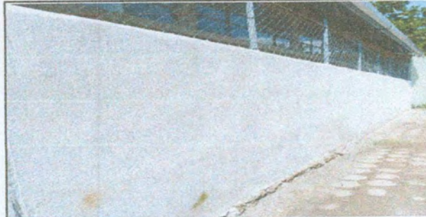
Foto 6: REPELLO MURO PERIMETRAL
